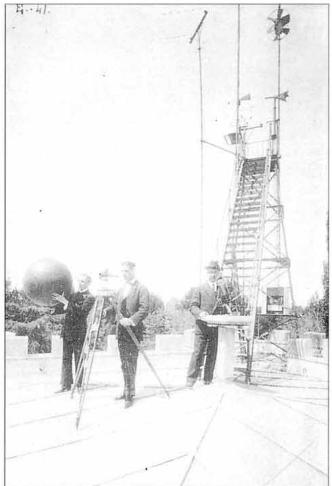
Primeros sondeos con globo piloto desde la torre de El Retiro, en 1913.
