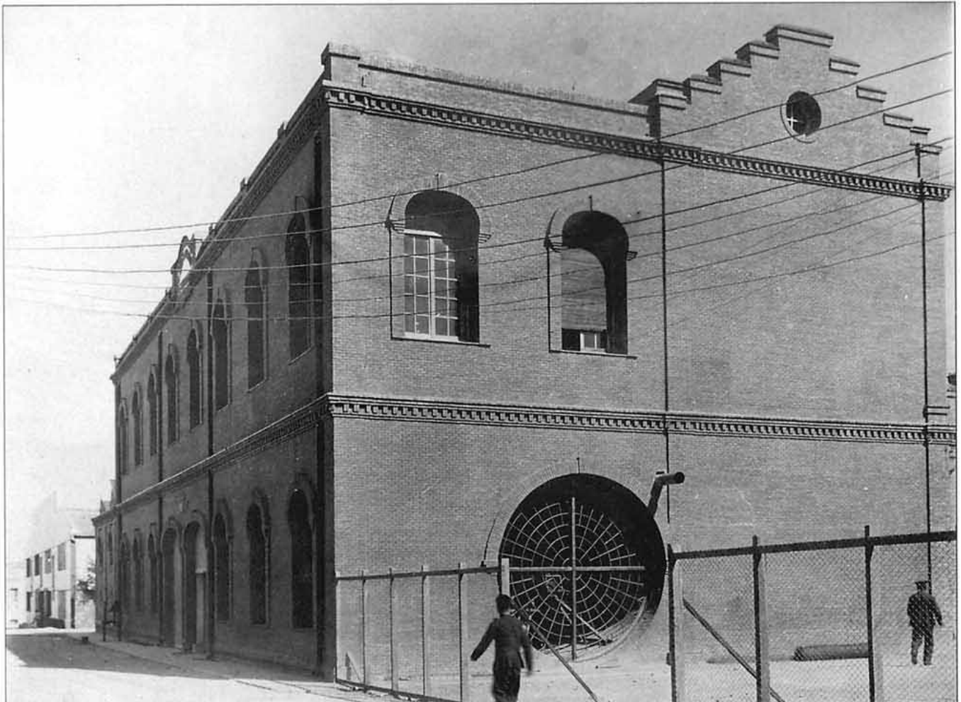
Edificio del Laboratorio Aerodinámico de Cuatro Vientos (Madrid) cuyo director fue el ingeniero militar-aeronáutico, Emilio Herrera.
