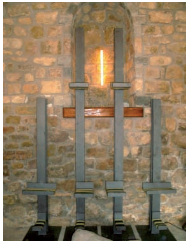
Procés de muntatge: disposició dels tubs metàl·lics.
