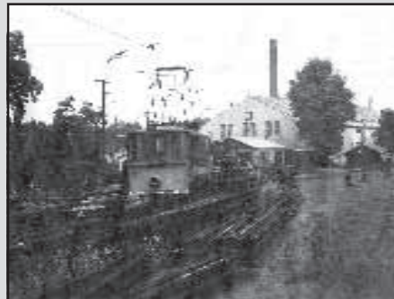
Montážní plocha před dílnou kolejových konstrukcí kolem roku 1980.
