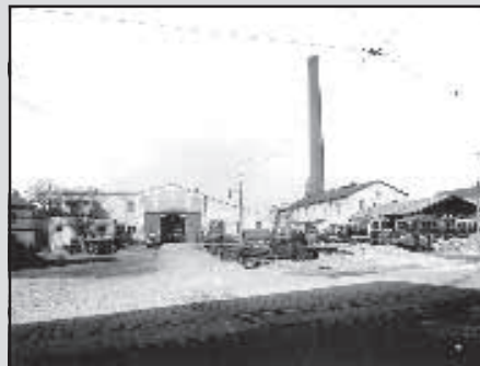
Kolejové konstrukce, nové i staré, se v Rustonce odkládaly na různých volných místech. Snímek pochází z počátku 20. let.
