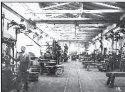
Tak to vypadalo ve strojovně dílen kolejových konstrukcí.
