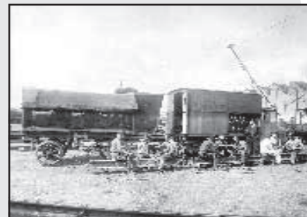
Svařování kolejí elektrickým obloukem na montážním dvoře v Rustonce před dílnou kolejových konstrukcí v roce 1927.
