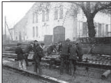
Ohýbání kolejnic před budovou dílen kolejových konstrukcí 28. října 1916. Foto: A. Novotný
