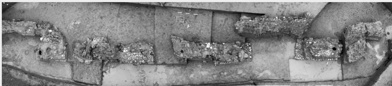
Fig. 2 - Panoramica dell'acquedotto visto dall'alto (foto L. Vitola).
