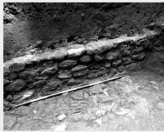
Fig. 6 - Particolare della struttura muraria.
