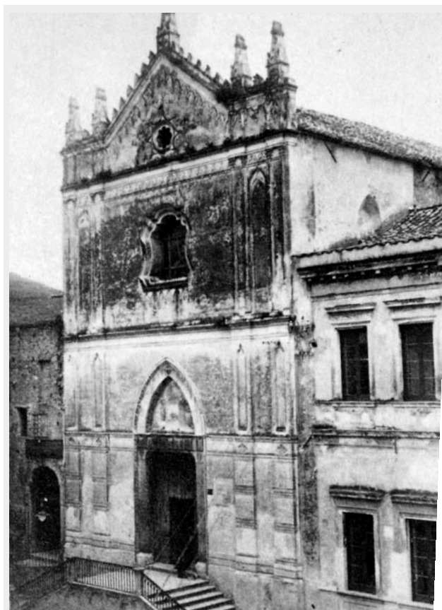
Fig. 3 - Eboli (SA), Chiesa di S. Francesco, - XIII sec. (ante 1224). Facciata barocca originaria (prima dei bombardamenti del 1943).
