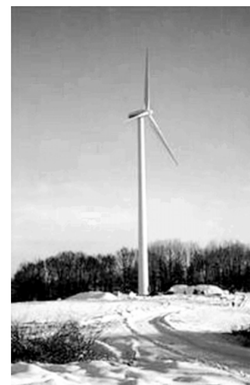
Rys. 3.6. Wirnik typu up-wind
