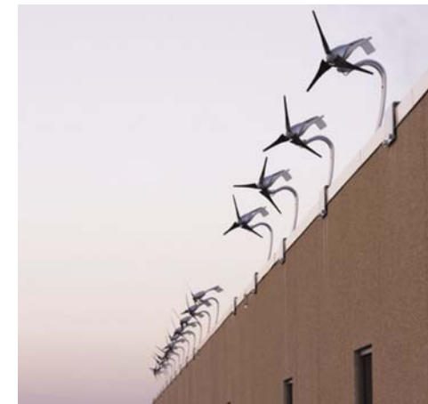
Rys. 3.31. Układ siłowni wiatrowych trójpłatkowych [ http://www.avint.com/ ]
