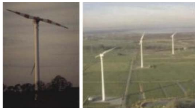
Rys. 3.14. Przykłady elektrowni wiatrowych z wirnikami jedno i dwupłatowymi [http://www.elektrownie.tanio.net]
