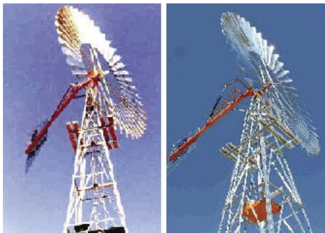
Rys. 3.17. Elektrownia wielopłatowa T550 [http://www.ekoland4.com]
