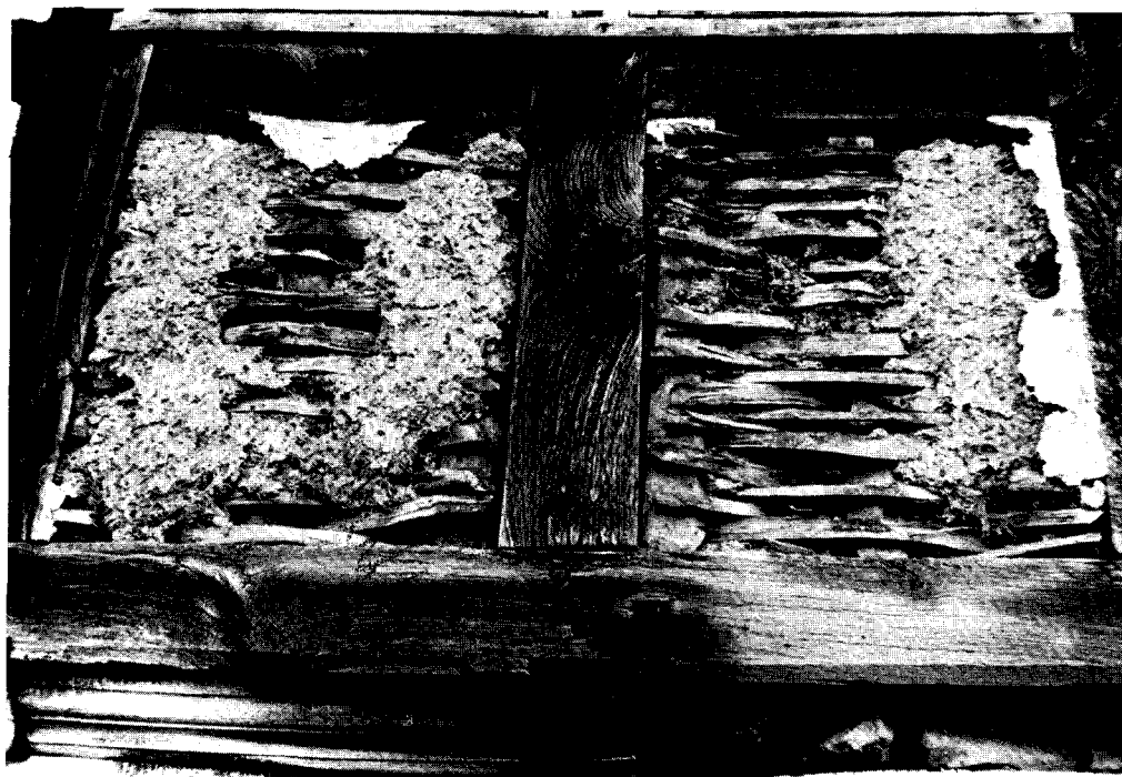
Tweyne querlaufende Zweige im Flechtwerk eines Gefaches (beim Fachwerkhaus). Vgl. Stiewern . (G. Hinker)
