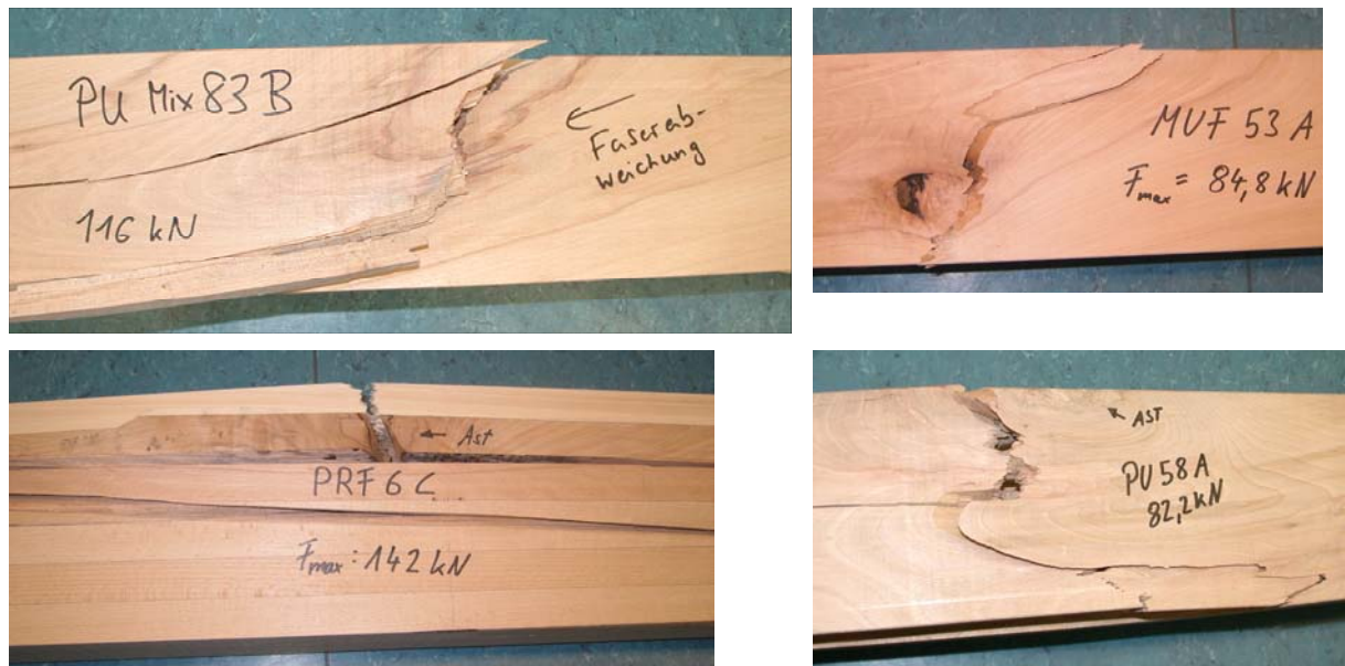
Abbildung 6.38: Zugversagen aufgrund von Fehlstellen
