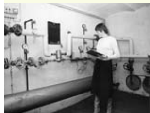
17.11.1978 – ein Hausanschluss in der Nauwieser Straße
