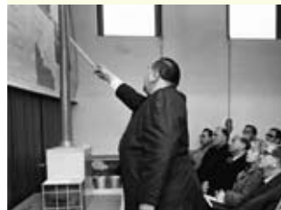
6.5.1966 – Besichtigung des Heizkraftwerks Römerbrücke
