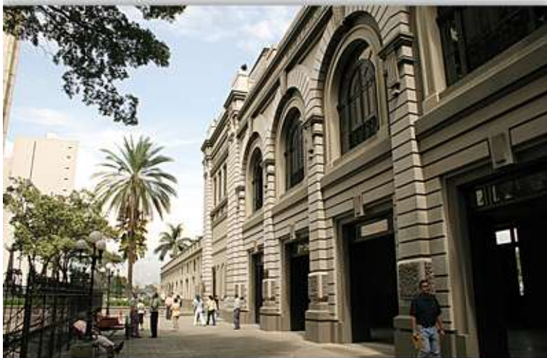
Estación del Ferrocarril de Antioquia.
