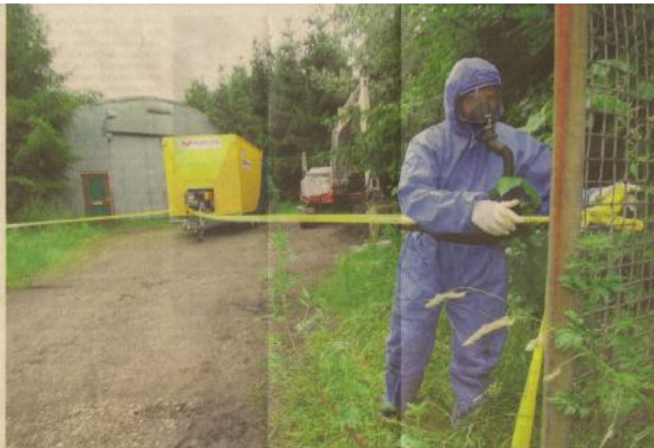
Bodemonderzoek van de voormalige stortplaats moet antwoord geven op de vraag of het terrein geschikt is voor andere doeleinden. De oude vijlven tot twintig meter diepe gaten zitten vol met asbest, HCH en ander mens- en milieuonveilig spul. Foto Rikbert Harink
