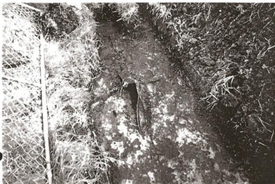
Het beschadigde folie (detail)
