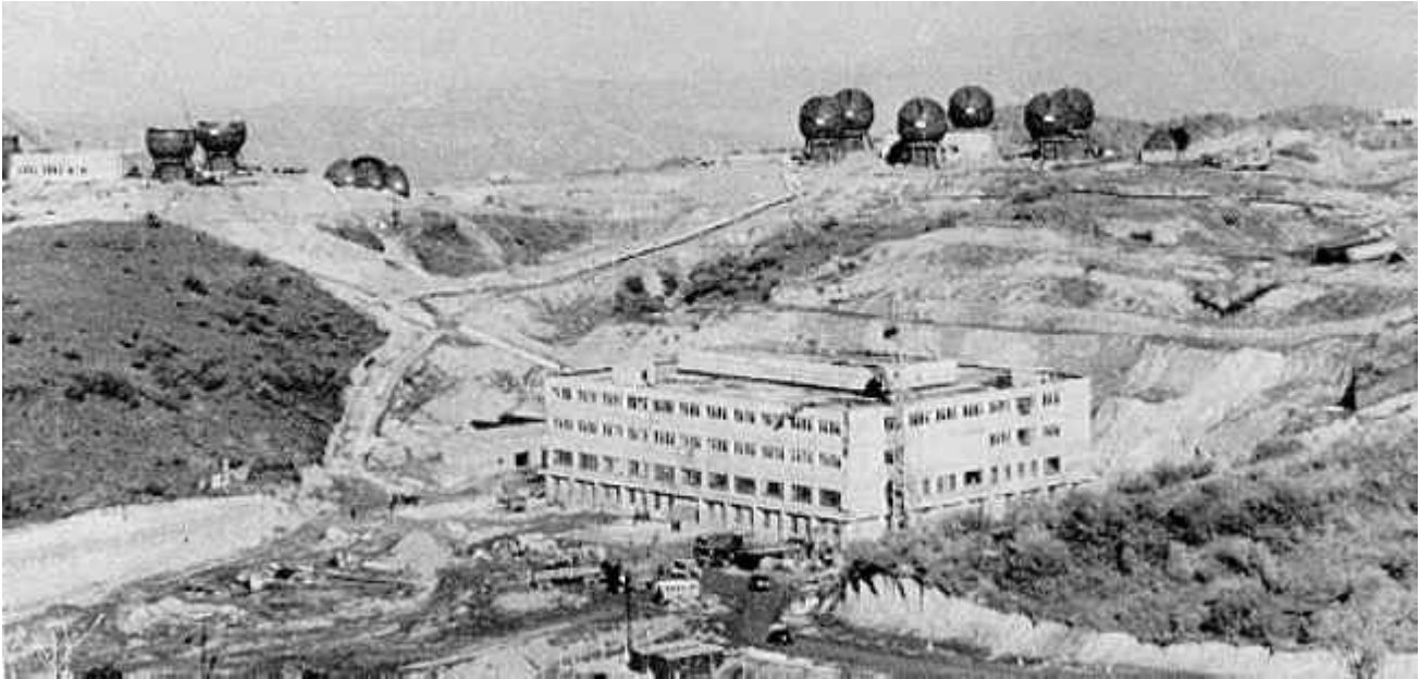
Комплекс "Окно" в процессе строительства в 80-е гг. (Фото газеты "Правда" с сайта FAS.)
