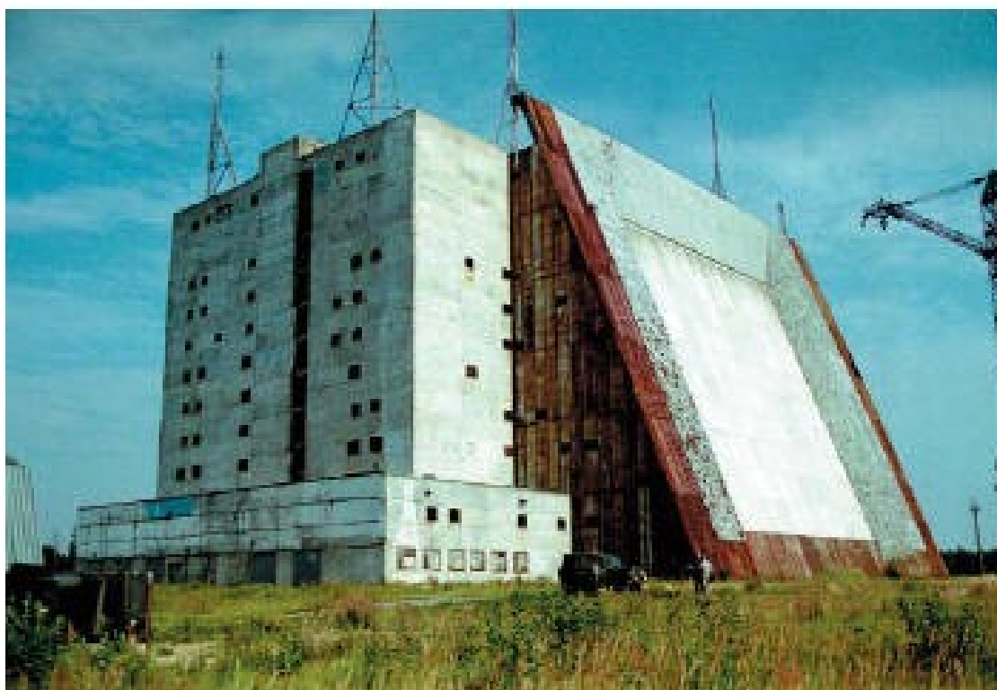
Строительство РЛС «Волга»
