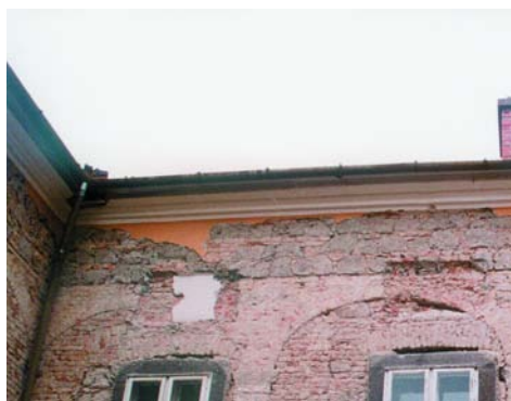
32. kép. Az elfalazott emeleti árkádok a nyugati szárny udvari homlokzatának emeletén
