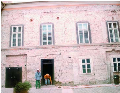
17. kép. A keleti szárny udvari homlokzata
