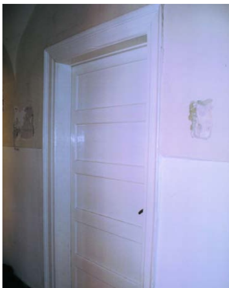
55. kép: 19. századi végi asztalos-szerkezetű ajtó (földszint nyugati folyosó)
