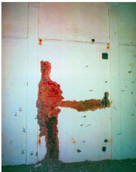
70. kép: Az ebédlő eredeti, befalazott ajtaja
