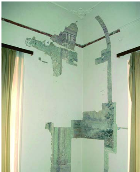
1. kép. Emelet 112-es helyiség. A nyílászárókat architektúrális festés keretezte. A festés a járószinttől a holkerig maradt meg. A barokk ablak eredetileg 40 cm-rel jobbra végződött. A másodlagos sarok stukkódíszre papírmáséból készült.
