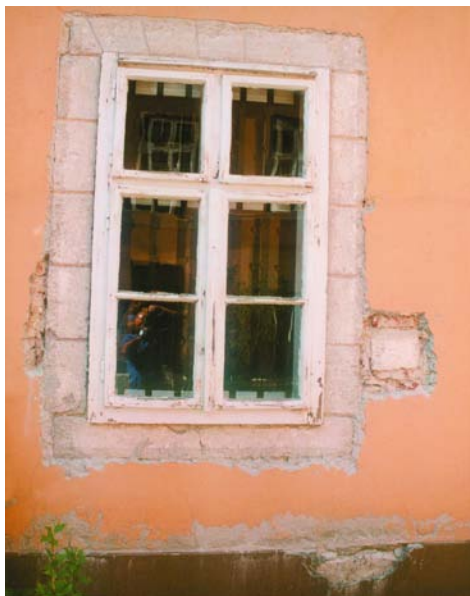
26. kép. Másodlagosan összeállított, levéselt tagozatú, utólag sávozott felületű barokk ablakkeret az udvari földszinti árkádok elfalazásában
