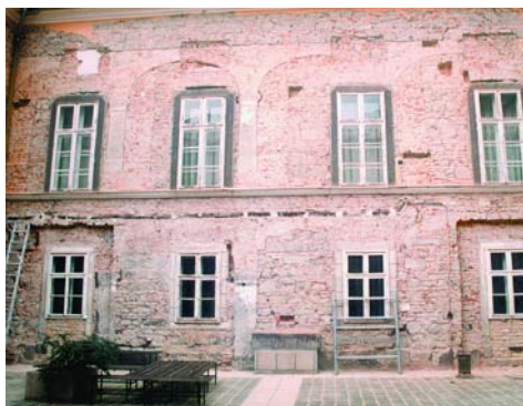
19. kép. A nyugati szárny udvari homlokzata
