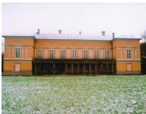
5. kép. Az északi homlokzat
