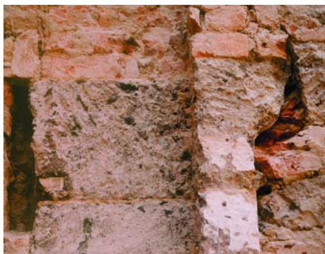
25. kép. A faltükrő kialakításakor megvésett barokk oszlopfejezet a nyugati szárny udvari homlokzatán
