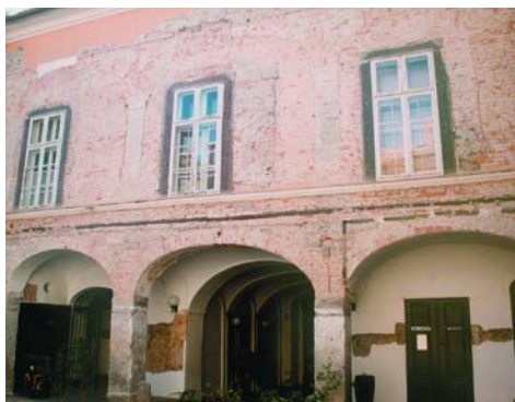
34. kép. Dupla széles második periódusú ablak a déli szárny udvari emeleti homlokzatának középső szakaszán
