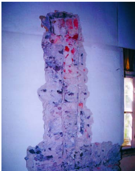
46. kép. A lefalazott és az új ablaknyílás az 5. számú helyiségben
