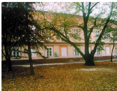
6. kép. A nyugati homlokzat
