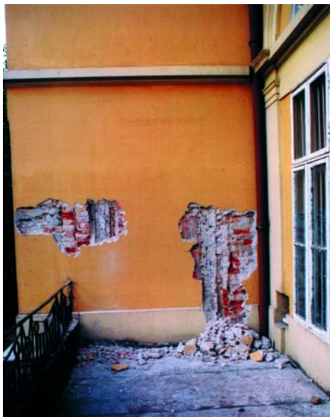
78. kép: Az északi teraszra vezető, elfalazott, kőkeretes ajtó
