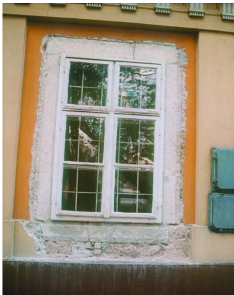
7. kép. Másodlagosan összeállított, levéselt tagozatú barokk ablakkeret a nyugati külső homlokzaton
