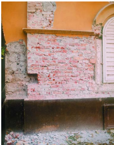
12. kép. Modern falköpeny a keleti homlokzat barokk kori szakaszán
