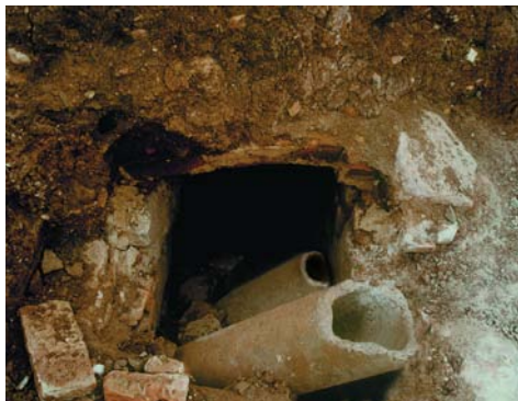
3. kép. Az ülepítőaknába vezető csatorna
