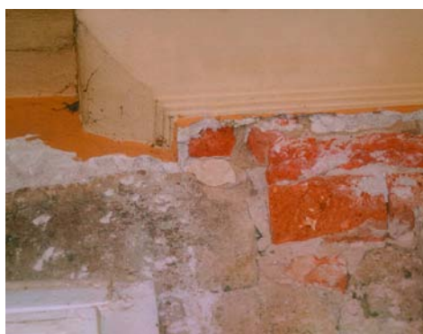
14. kép. A középrizalit megduplázott falpillére a klasszicista vakolat felett
