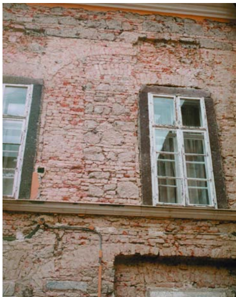
35. kép. Klasszicista emelés a nyugati szárny udvari homlokzatának felső részén
