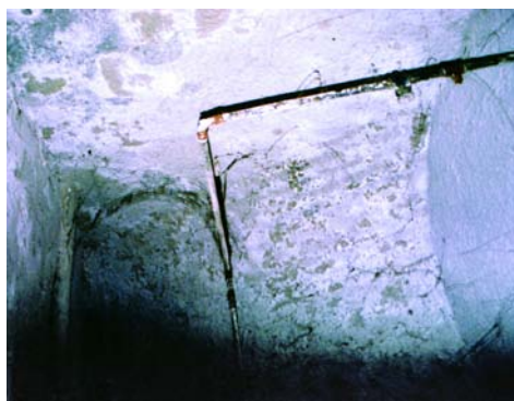
36. kép. Dongaboltozat a 015. számú helyiségben
