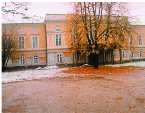
3. kép. A keleti homlokzat
