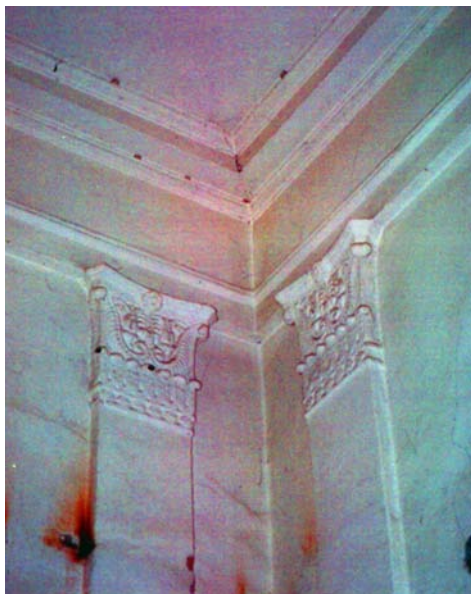
69. kép: Stukkófejezetes pilaszterek az egykori ebédlőben (103. helyiség)
