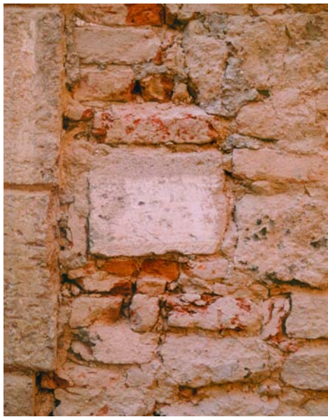
24. kép. Másodlagos helyzetű barokk nyílászkeret-töredék a nyugati szárny egyik udvari ívének befalazásában
