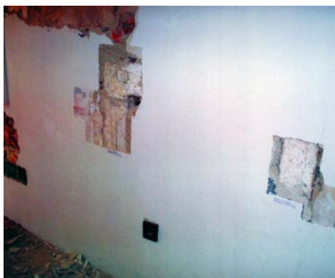
66. kép: Barokk fűtőnyílás a 114. számú helyiségben
