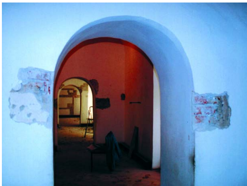
79. kép: 20. századi félköríves áttjárók a 108. és 111. számú helyiségek között
