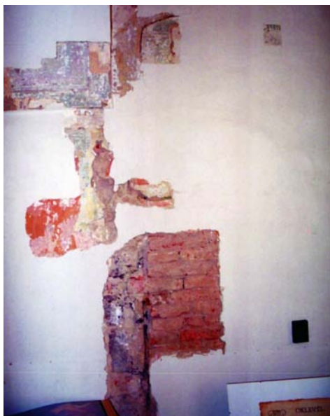
45. kép. Befalazott barokk ablak a 43. számú helyiségben
