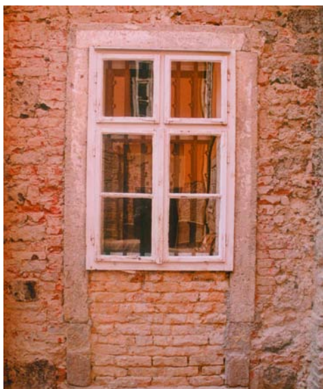
27. kép. Másodlagosan összeállított, levéselt tagozatú, barokk ajtókeret, melyet utóbb ablakká alakítottak, a nyugati szárny az udvari földszinti falának északi faltükrében
