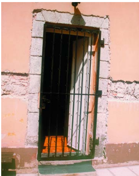
28. kép. Kőkeretes ajtó az északi szárny földszinti, udvari homlokzatán
