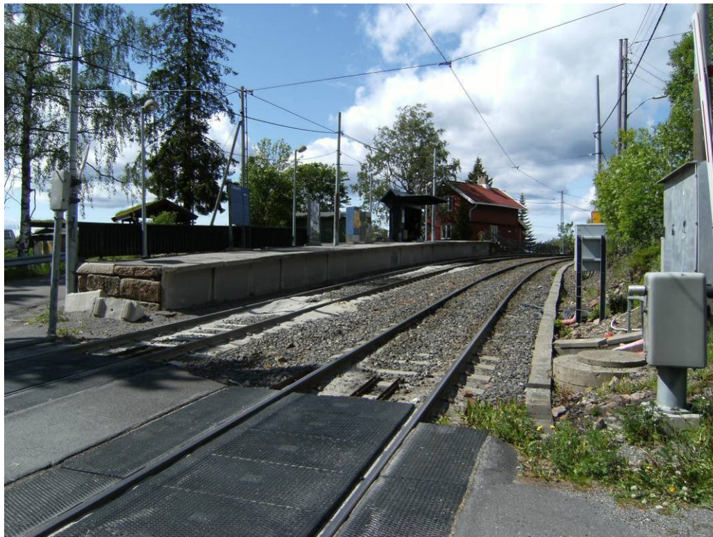
Lillevann stasjon 2009. Merk synlig granitt i plattformens sidekant. Foto: Byantikvaren/Reusch
