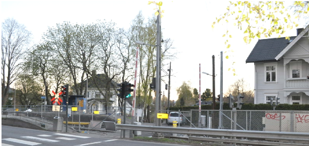
Steinerud stoppested med leskur fra 1970-tallet. Stasjonsbygning oppført ca 1900 med venterom/leiligheter til høyre. Foto: Byantikvaren/Høvås 2010
