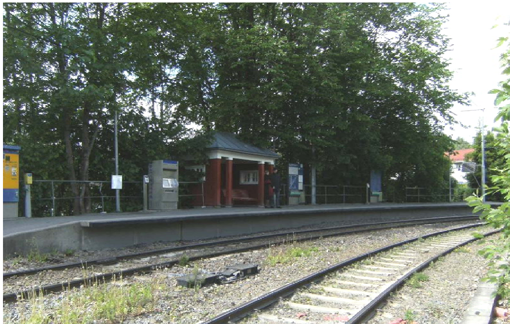
Glosimodts paviljong på Gulleråsens inngående plattform. Foto: Byantikvaren/Reusch 2009
