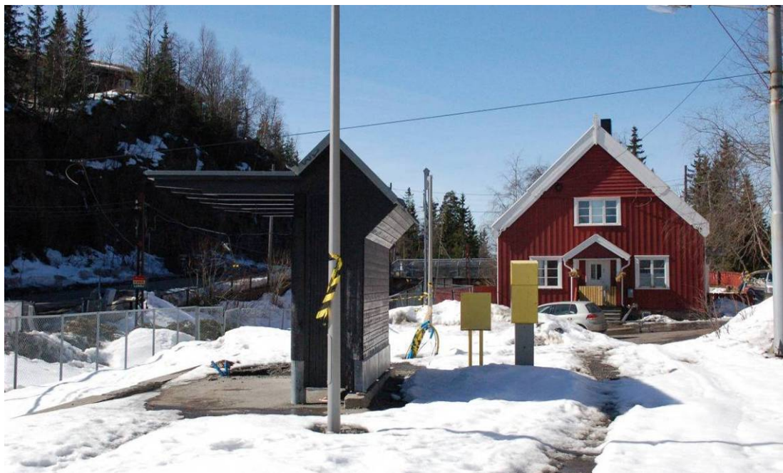
Voksenkollen 2010. Glosimodts stasjonsbygning fremstår svært forenklet i fht. opprinnelig utseende. Se foto neste side. Bygningen har fått ny fargesetting, og den doble inngangsdøren og de dekorative dør- og vindusoverstykker er fjernet. Vindskiene med dekorative detaljer er derimot intakt. Arne Henriksens leskur i forgrunnen. Foto: Byantikvaren/Høvås
