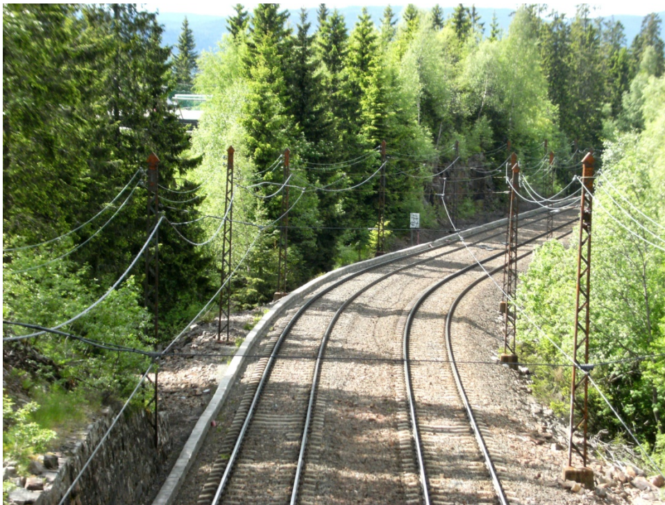
Skinnegangen med fagverksmaster sett fra den senere broen. Byantikvaren/Reusch 2009
