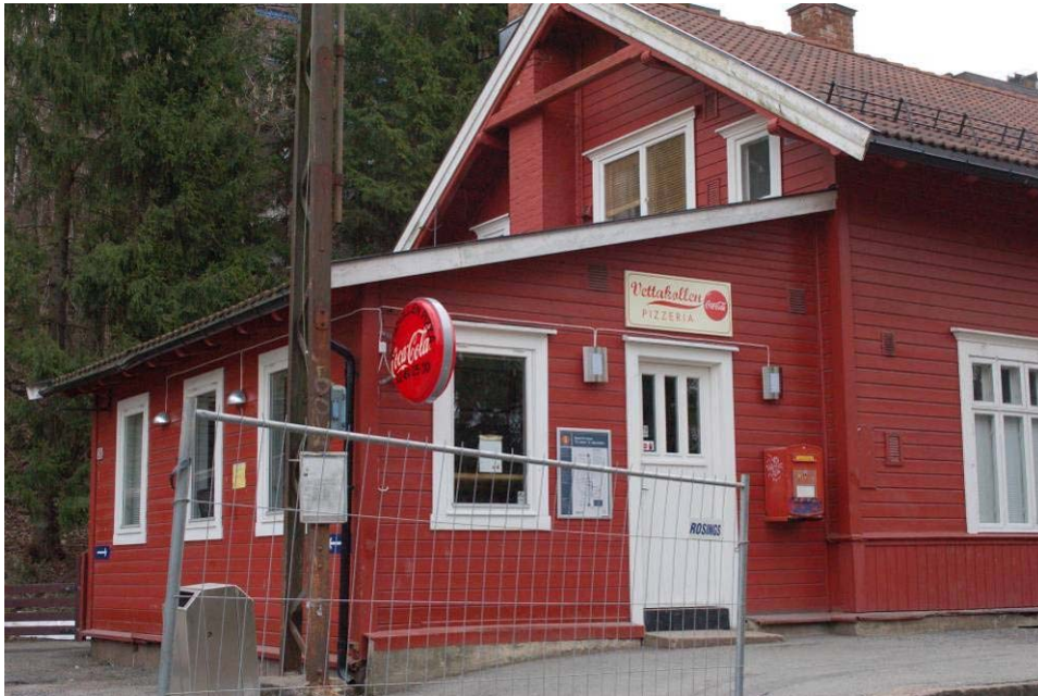
Den opprinnelige godsekspedisjonen med uheldig nyere belysning og skilting, og stasjonsbygningen i to etasjer. Foto: Byantikvaren/Reusch 2010
