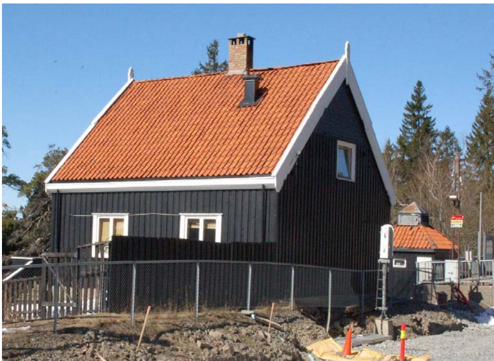
Stasjonsbygningen på Skogen fremstår i dag forenklet, og uten vinduslemmer, vindusoverstykker og inngangsparti på gavl mot banen. Foto: Byantikvaren/Høvås 2010
