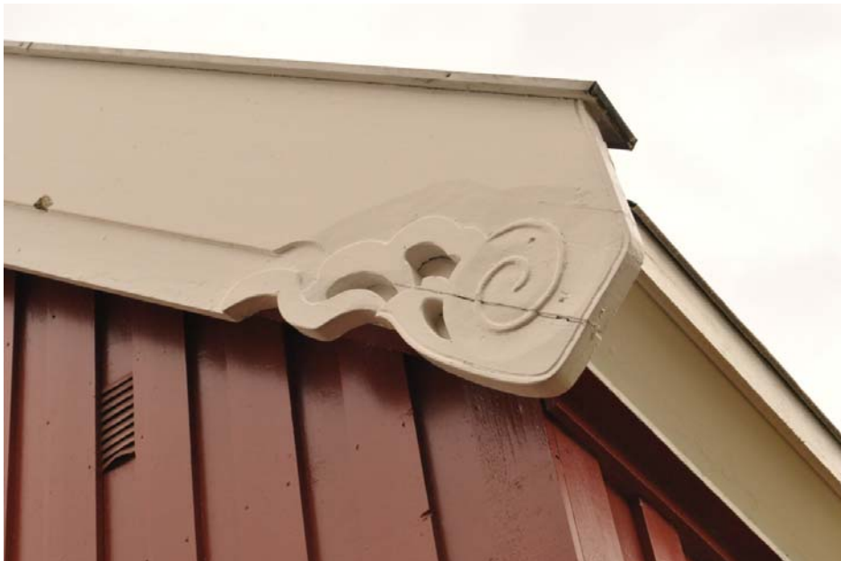
Stasjonsbygningen på Holmenkollen stasjon har bl.a. intakte mønespir og vindskidetaljering. Foto: Byantikvaren/ Elisabeth Høvås 2010
