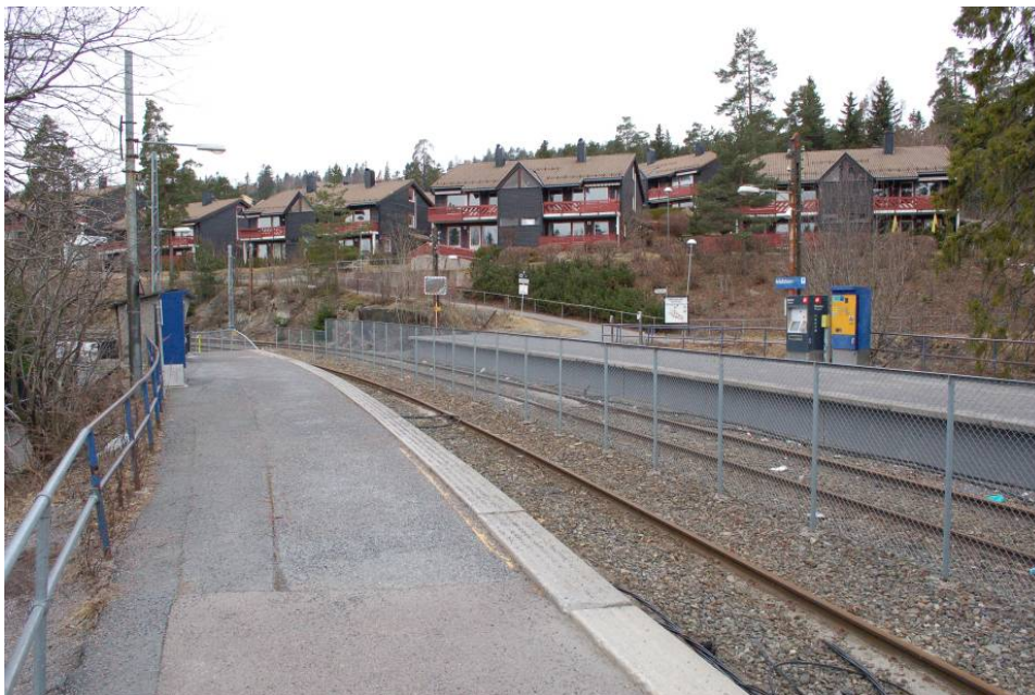
Midtstuen stasjon sett fra sør. Foto: Byantikvaren/Høvås 2010
