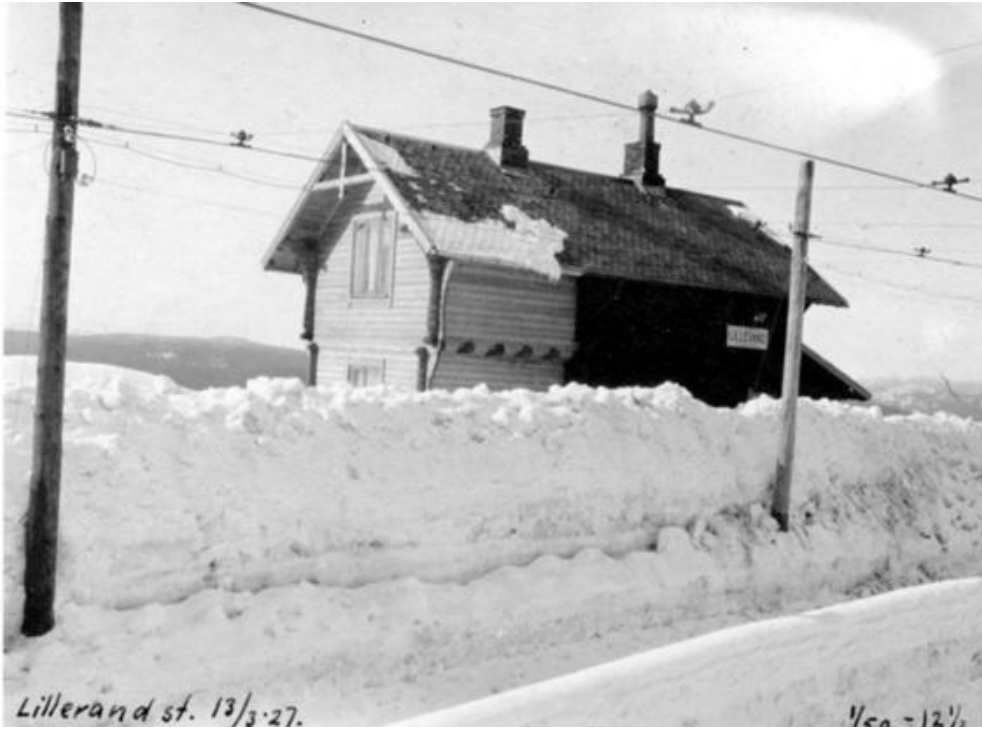
Lillevand stasjon, 1927. Overdekket inngangsparti på gavlveggen er fjernet og bygningen er forlenget og har fått en ekstra pipe. Foto: AS Holmenkollbanen, Oslo byarkiv
