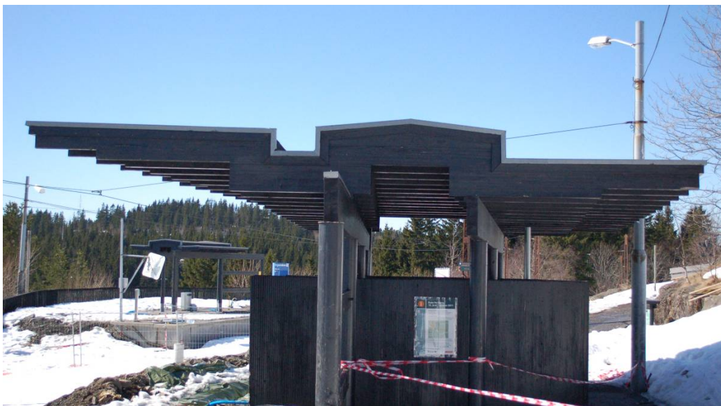
Leskur med s-formet levegg på inngående side, også formgitt av arkitekt Arne Henriksen, 2010. Vi skimter letaket på utgående side i bakgrunnen. Foto: Byantikvaren/Høvås
