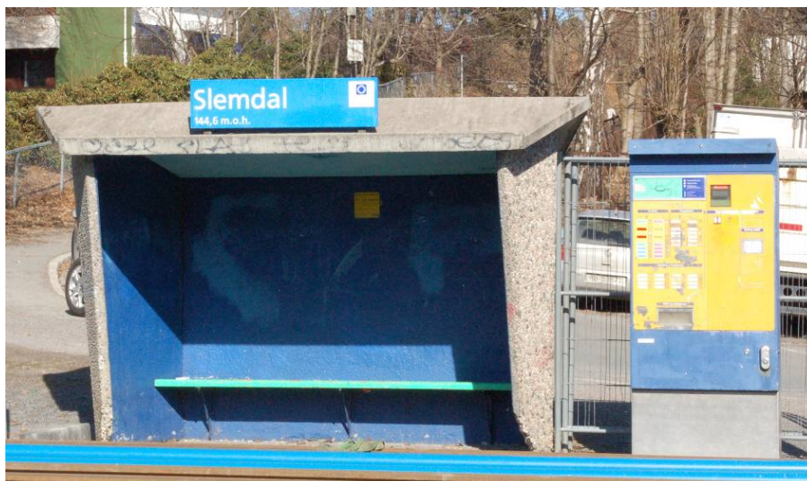
Standard leskur i naturbetong fra 1970-tallet. Brukt over store deler av landet. Foto: Byantikvaren/Høvås 2010
