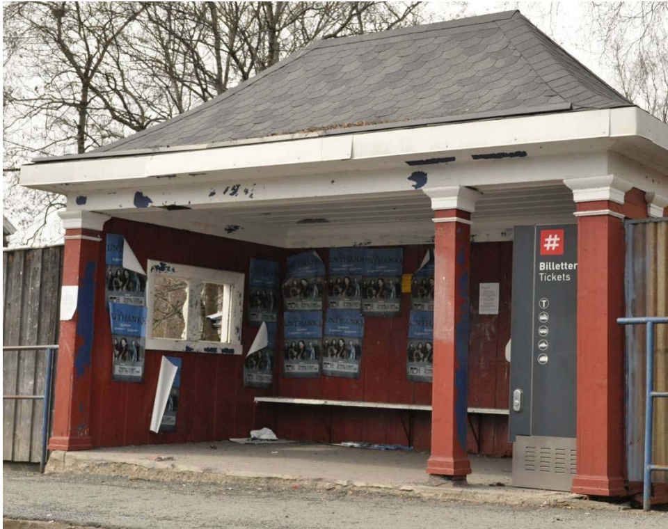
Fronten mangler en søyle, den er lagret og skal monteres. Foto: Byantikvaren/Høvås 2010
