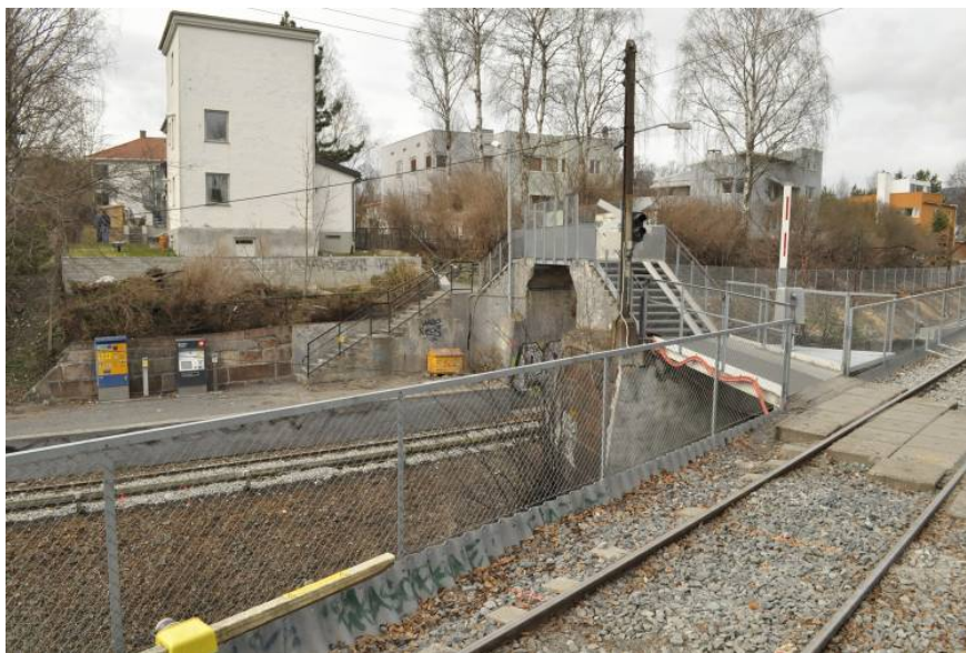
Frøen, 2010. Krysning i plan på utgående plattform, videre via gangbro over Sognsvannsbanens trasé og inngående linje. Bilde sett fra utgående plattform. Foto: Byantikvaren/Høvås
