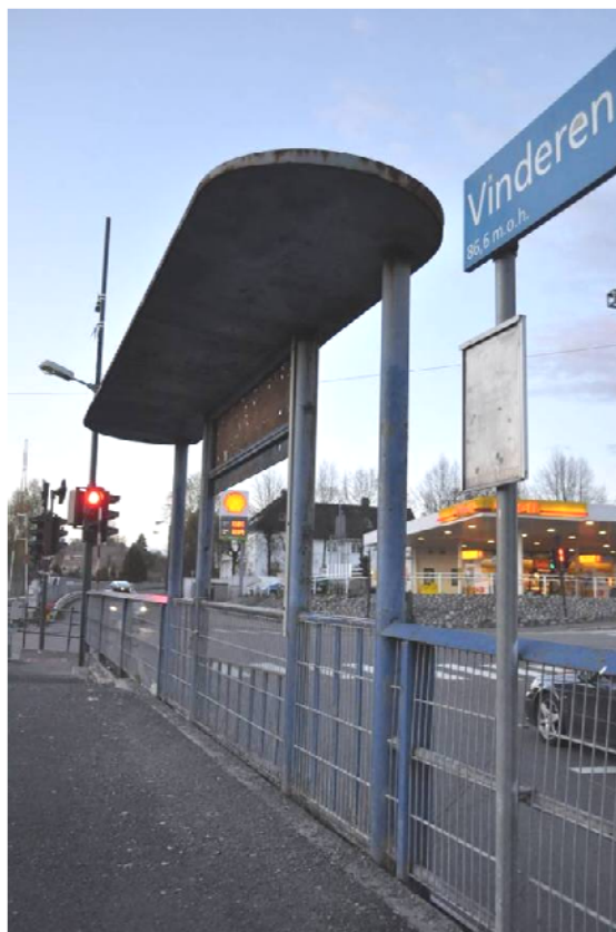
Utgående plattform med letak fra rundt 1940. Foto: Byantikvaren/Høvås 2010
