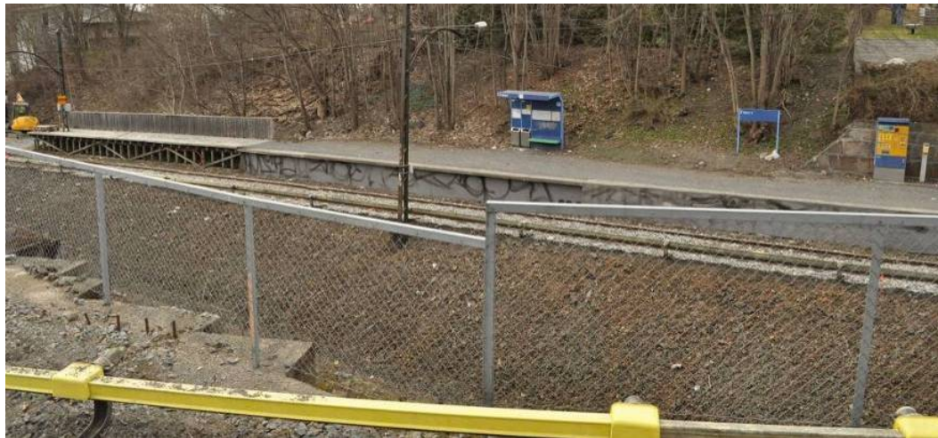
Inngående plattform. Foto: Byantikvaren/Høvås 2010
