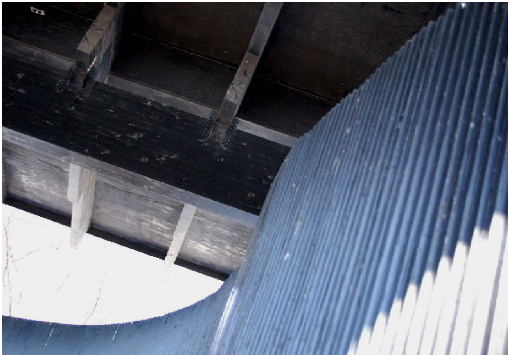
S-formet vegg utført i lektepanel. Foto: Byantikvaren/Høvås 2010
