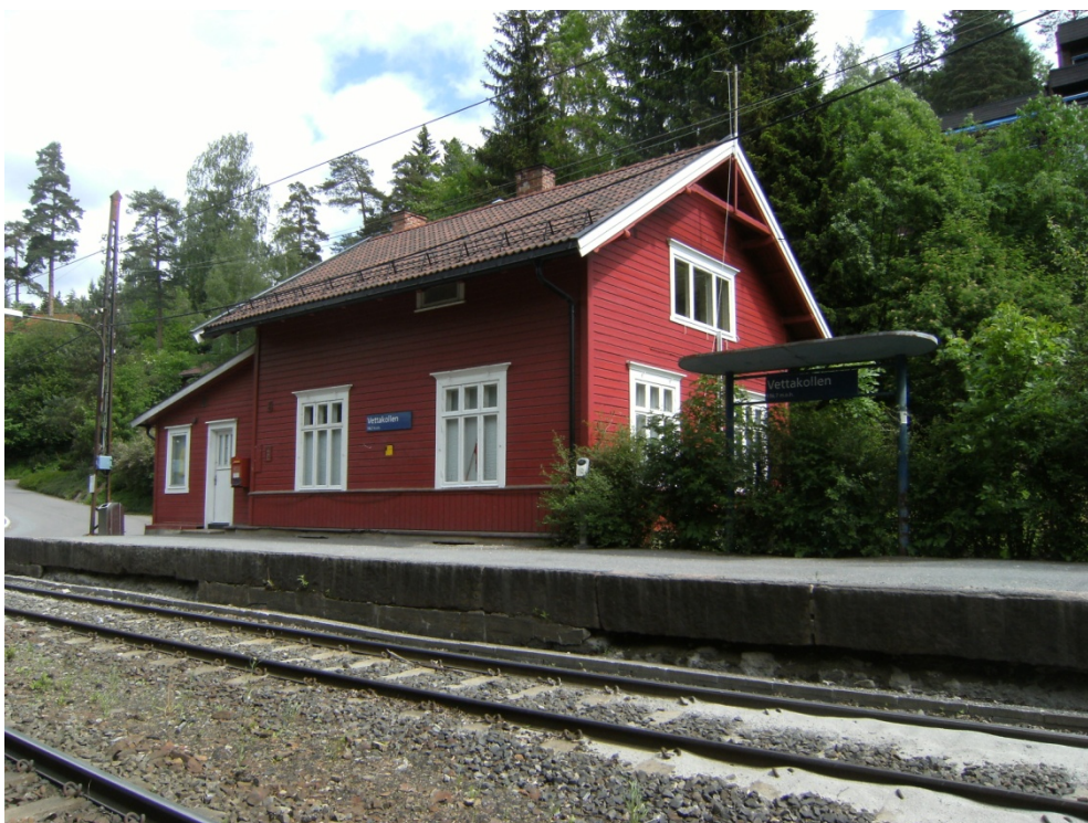
Stasjonsbygningen med senere tilbygg, samt nyere letak. Byantikvaren/Reusch 2009.
