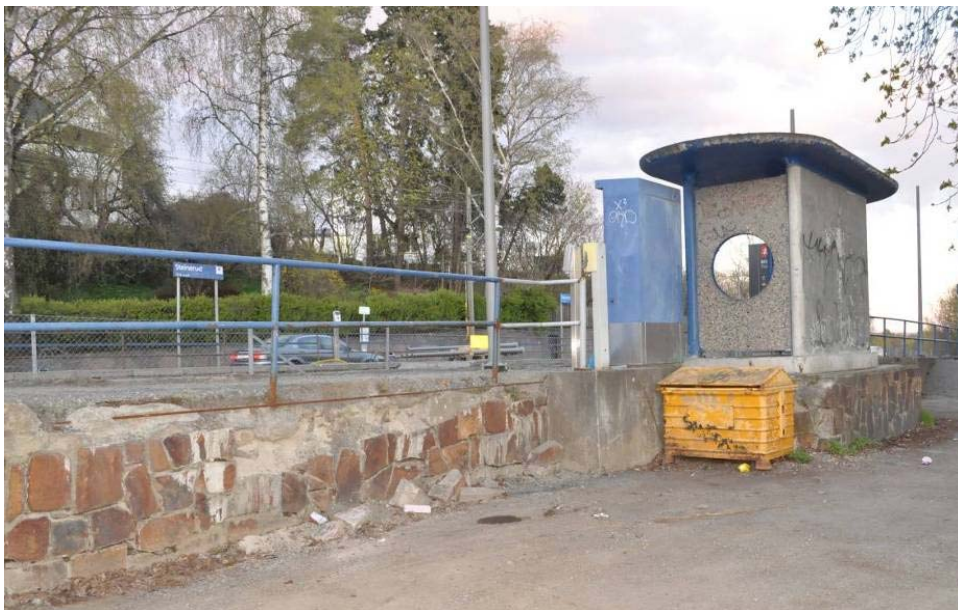
Leskur i naturbetong, tegnet av arkitektene Telje-Torp-Aasen på 1970-tallet. Det opprinnelige granittfundamentet kan tyde på at en av Glosimodts ventepaviljonger kan ha stått her. Foto: Byantikvaren/Høvås 2010
