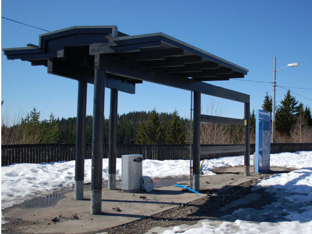
Åpent leskur med skistativ på utgående side, tegnet av arkitekt Arne Henriksen, 2010. Foto: Byantikvaren/Høvås
