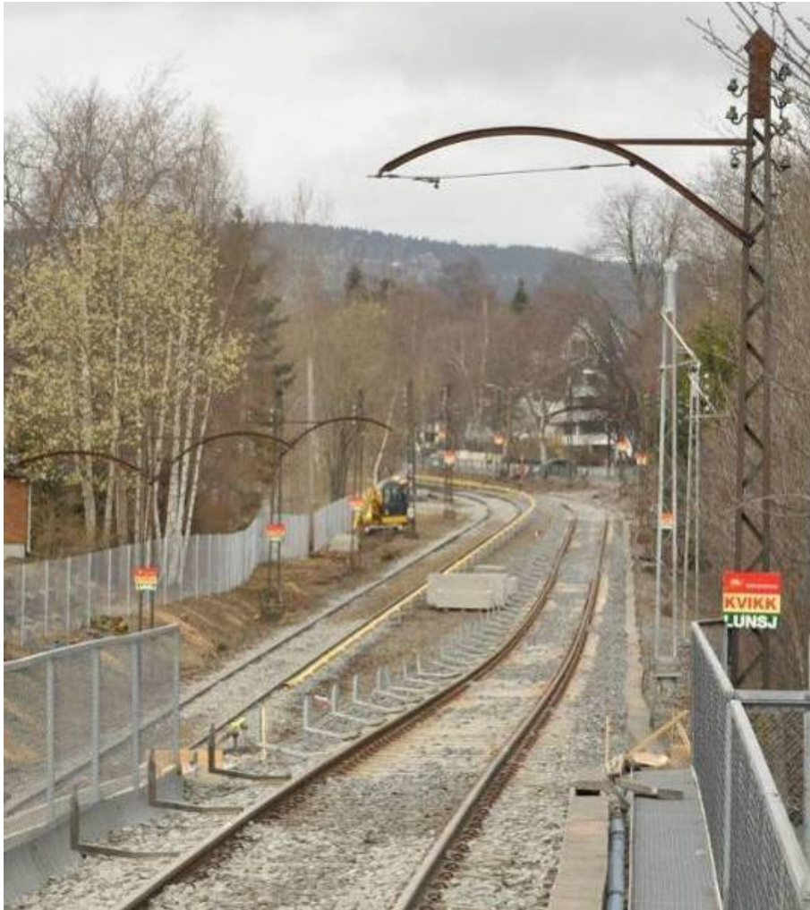
Fagverksmaster med én arm på Frøen. Her ser vi traseen videre nordover fra utgående plattform. Foto: Byantikvaren/Høvås 2010
