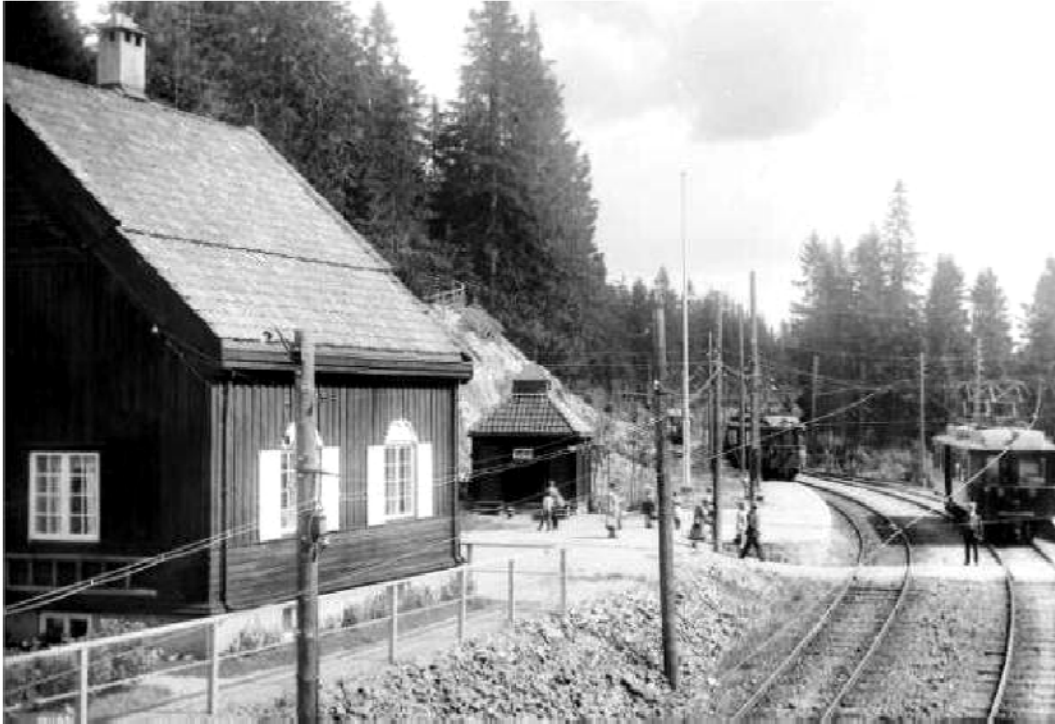
Opprinnelig organisering av Voksenkollen stasjon med krysning i plan, og Erik Glosimodts stasjonsbygning med tilhørende privét. Foto: Ca. 1930, Anders Beer Wilse, Oslo byarkiv
