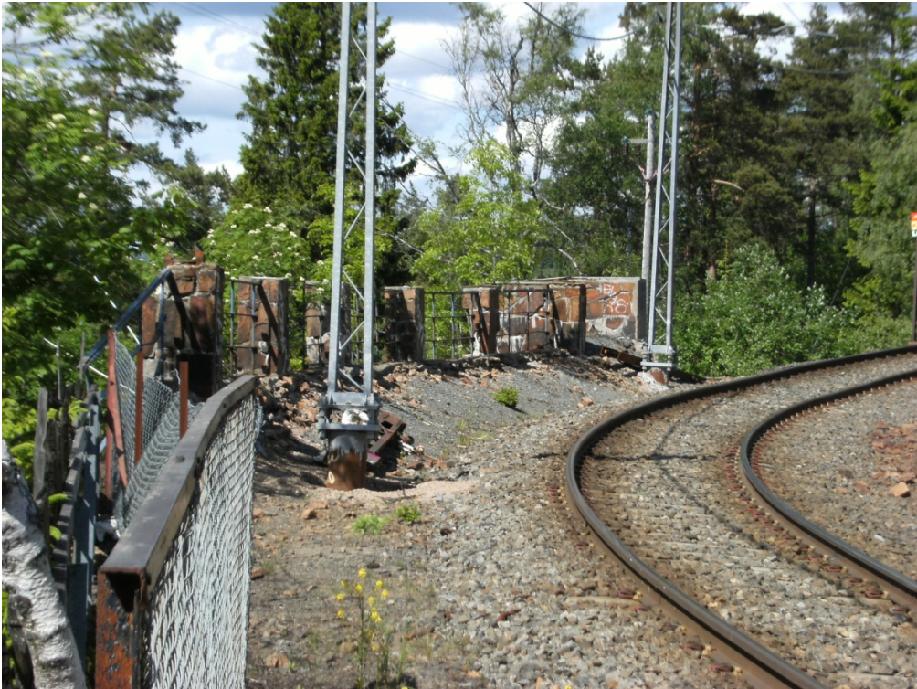
En opprinnelig forstøtningmur med stolper og rekkverk, sikrer banetraséen i svingen etter Lillevann stasjon. Foto: Byantikvaren/Reusch 2009
