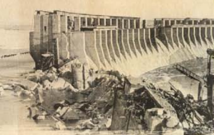
Разрушенная ДнепроГЭС, 1943 год.
