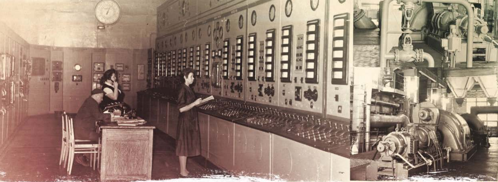
Главный щит управления и турбинное отделение Каширской ГРЭС.
