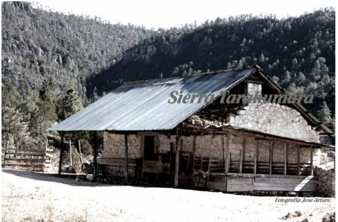
Con tapanco, piedra y zarzos en el portal.
