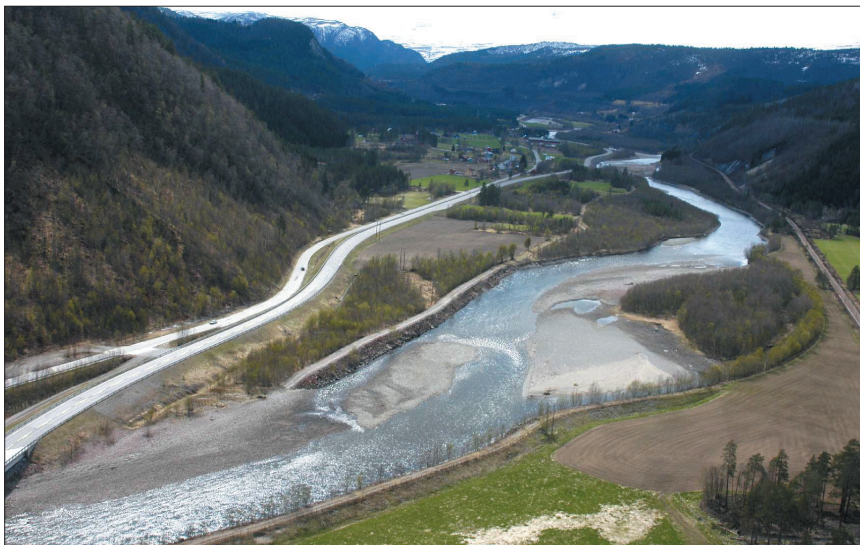
Saltdalselva ved Røklund. Inngrep i form av riksvei, jernbane og flomvern
