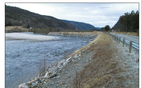
Veifylling ved Nordnes som er anlagt ut i vassdraget
