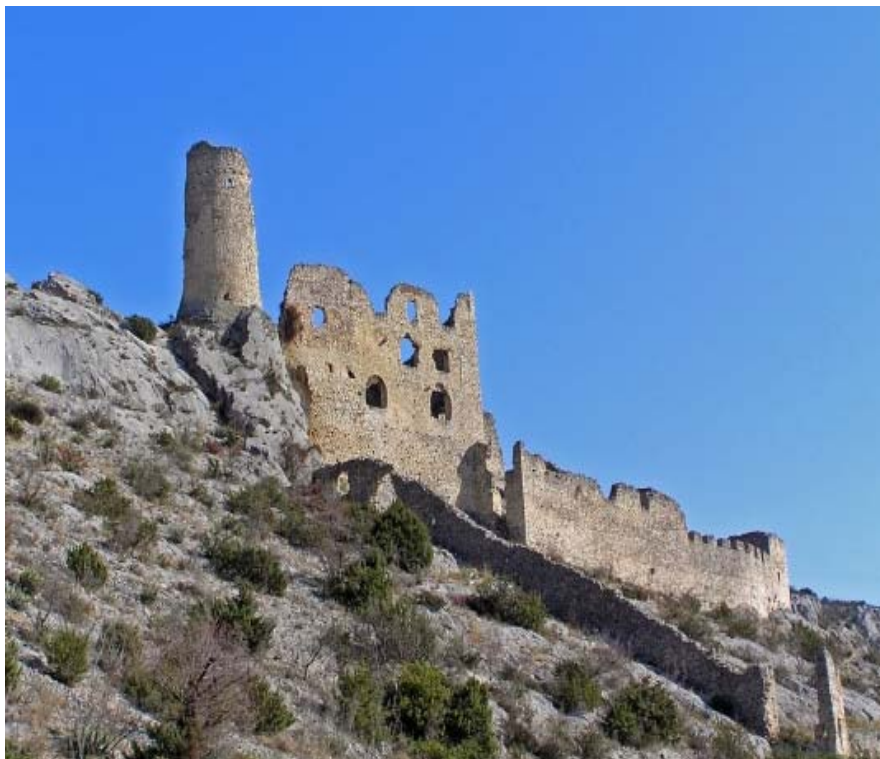
Ostatci tvrđave Ključica
