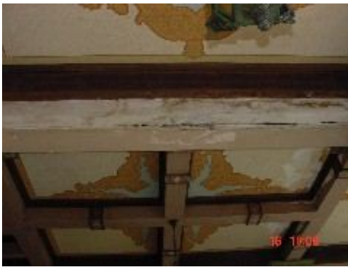
Fotos 21 - 22. Vigas en tercer nivel. Muestra humedad.
