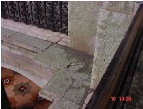
Foto 41. Detalle en cornisa. Tercer Nivel.
