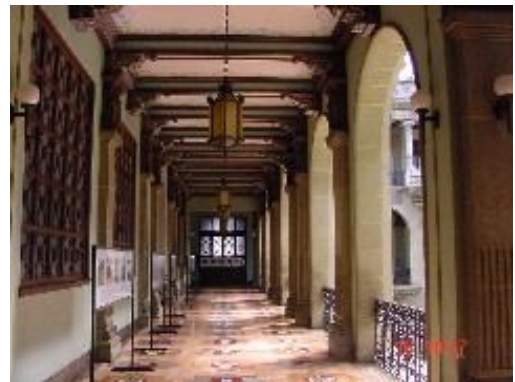
Foto 33. Pisos de corredor. Segundo Nivel
