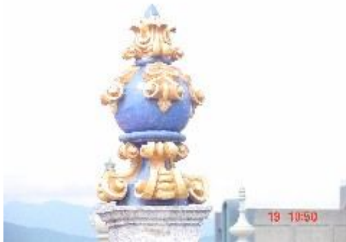
Fotos 55. Ornamentos en Cerámica Vidriada. Pináculo en barandas de patios. Cuarto Nivel.
