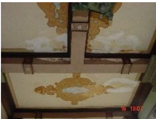
Foto 30. Cielo decorado sobre losa. Tercer Nivel. Muestra humedad.
