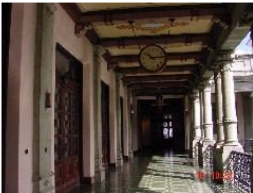
Foto 32. Pisos de corredor. Tercer Nivel
