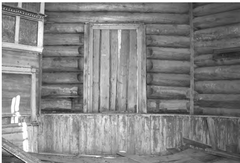
Рис. 4. Южная стена изнутри. Видны следы первоначального дверного проема и пристенных лавок, справа — остаток окна-щели
