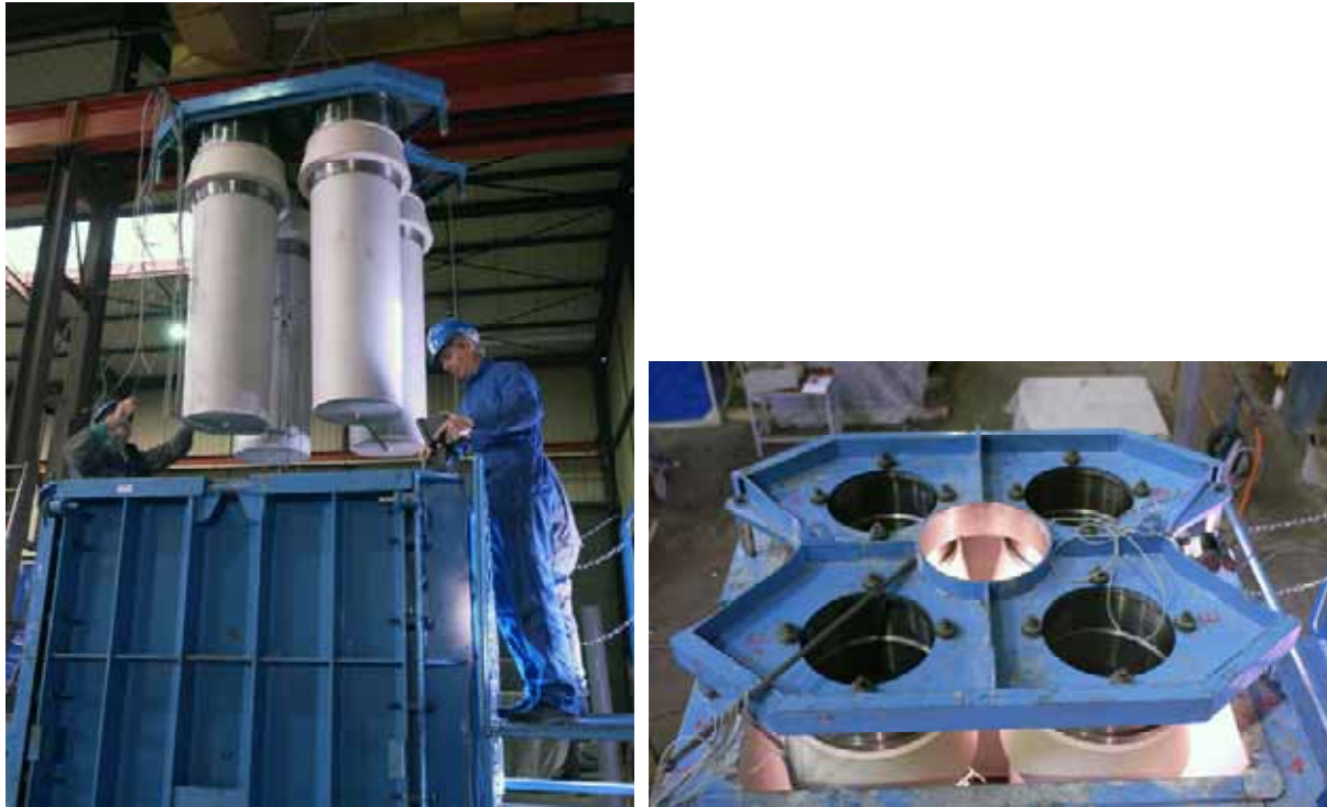
Figure 4.1.10 Mise en place des noyaux dans le moule du colis standard B5 avant coulage
