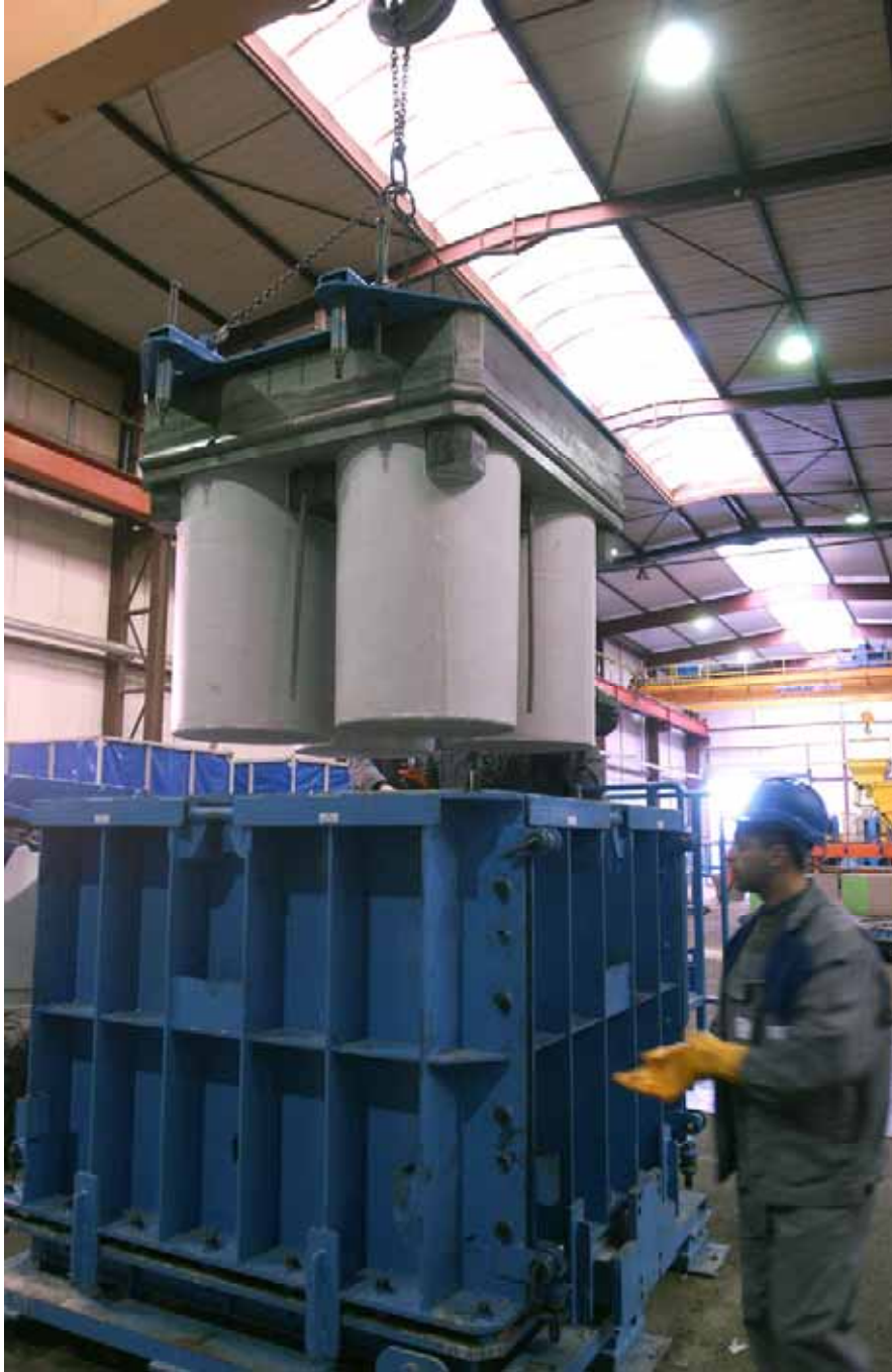
Figure 4.1.8 Mise en place des noyaux dans le moule du colis standard B2 avant coulage
