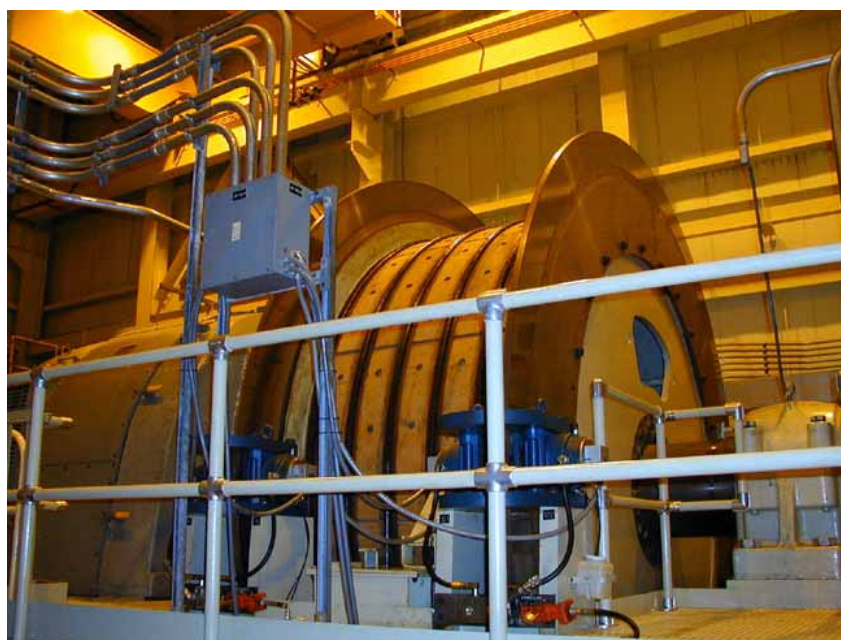
Figure 9.2.5 Poulie Koepe du puits de descente des colis du WIPP (USA)
