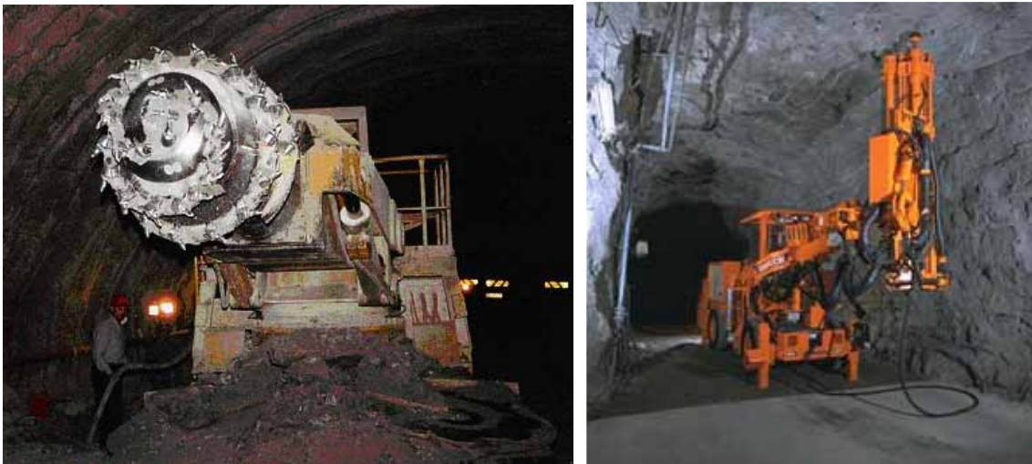
Figure 5.1.22 Exemples de machine à attaque ponctuelle et de jumbo de boulonnage
