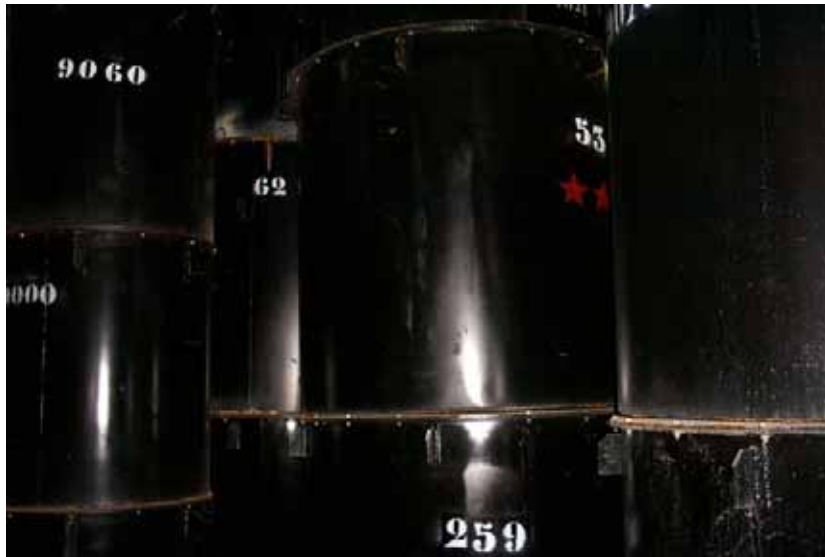
Figure 3.2.7 Conteneur en acier non allié utilisé pour le reconditionnement des conteneurs béton 1 800 litres
