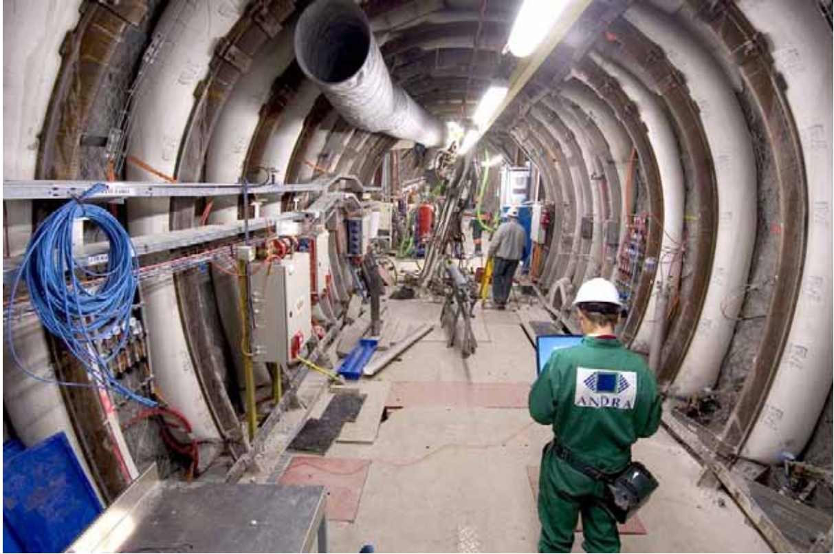
Figure 2.3.5 Vue de la galerie à -445m du laboratoire de recherche souterrain de Meuse/Haute-Marne
