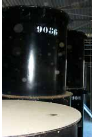
Figure 3.2.5 Conteneur en acier non allié utilisé pour le reconditionnement des conteneurs béton 1 000 litres
