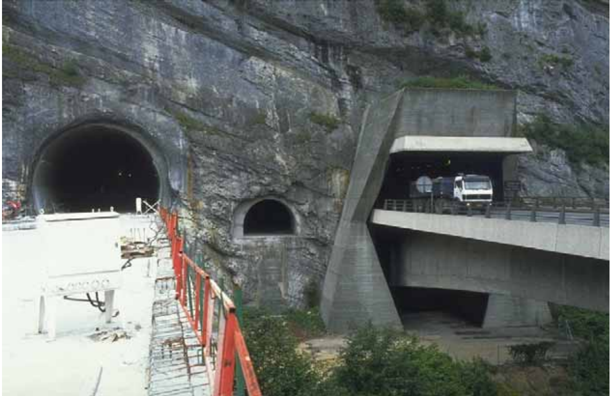
Figure 2.3.4 Entrée du tunnel de Chamoise (à gauche tube en construction, au centre galerie de reconnaissance, à droite tube en exploitation)
