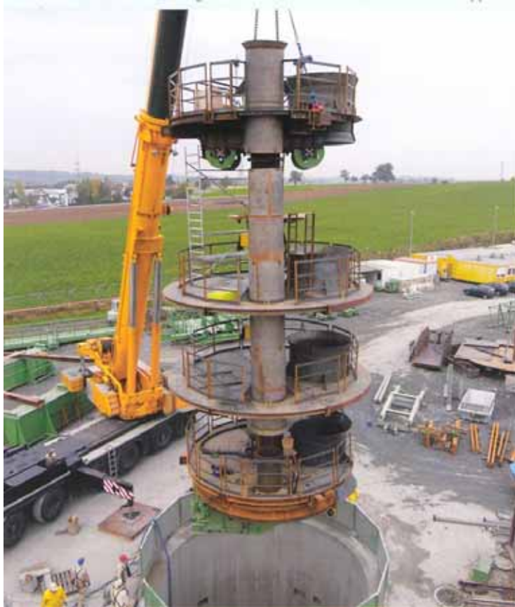
Figure 7.5.1 Plateforme de fonçage de puits (mine de sel de Konradsberg – Heilbronn – Allemagne)
