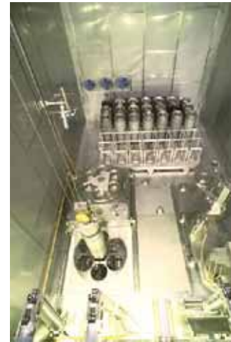
Figure 9.1.4 Cellule de déchargement et d'entreposage de colis primaires (doc. Cogema)
