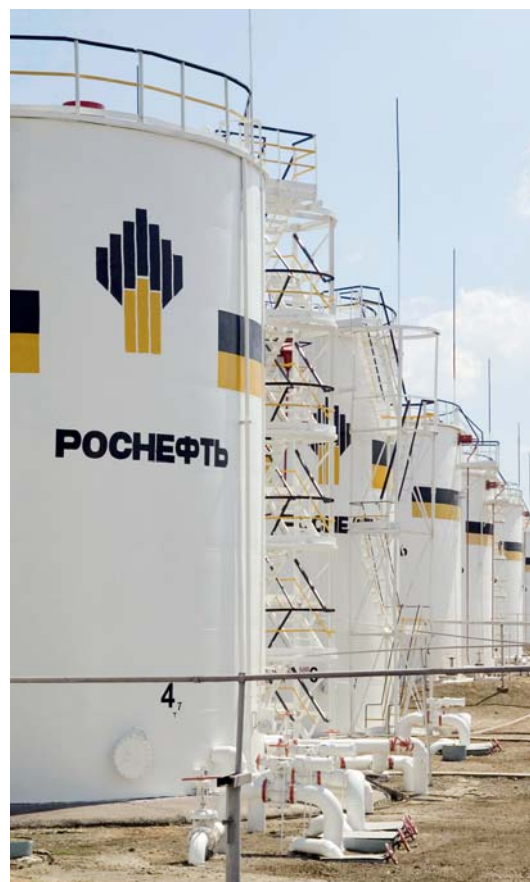
Резервуары ООО «РН-Краснодарнефтегаз»
