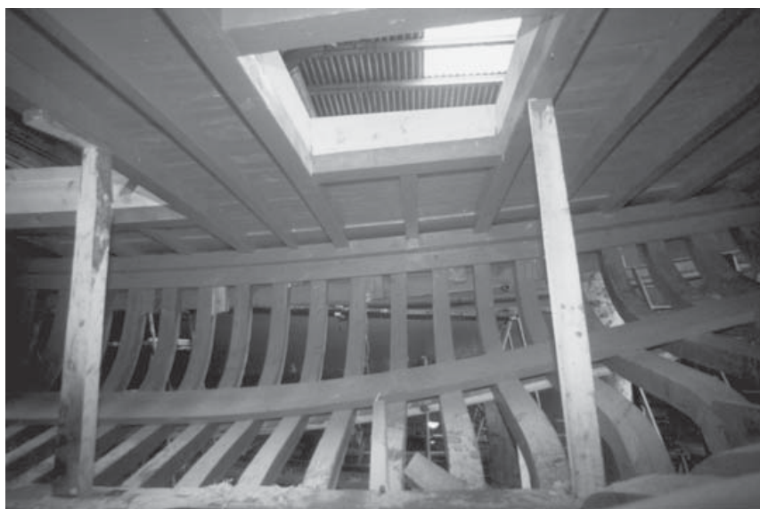
Figura 78.- Baos, medios baos y balderas.
