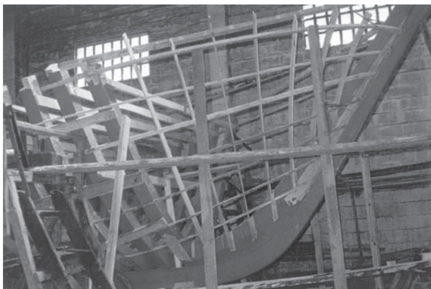
Figura 74.- Elaboración de las cuadernas de proa con ayuda de rixideiras en el Astillero Triñanes Domínguez en Chazo-Boiro. (Fotografía de F.J. Alonso González).
