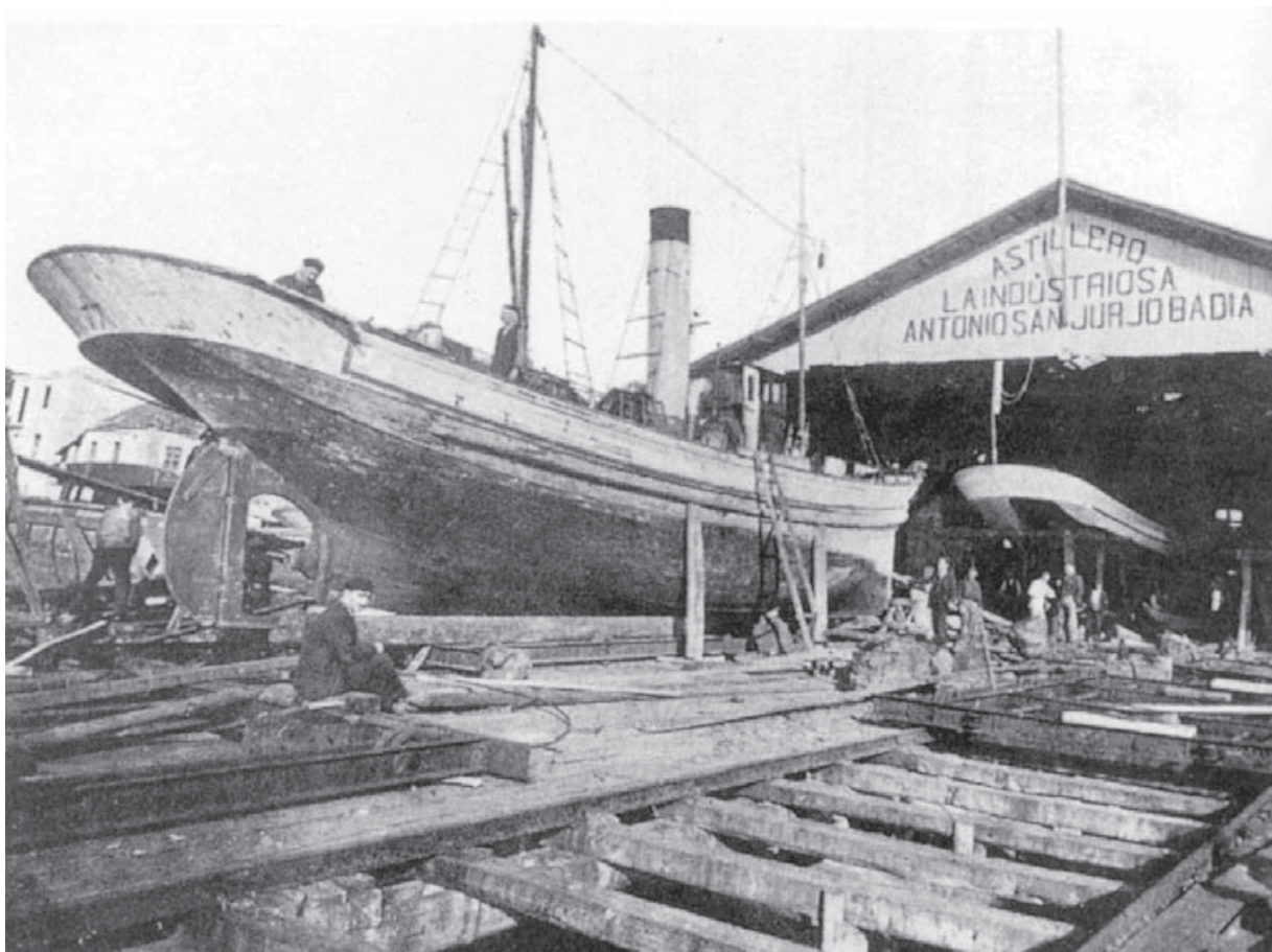
Figura 49.- Popa de rabó de galo de un pesquero a vapor construido hacia 1922 en el astillero de Sanjurjo Badía, de Vigo.
