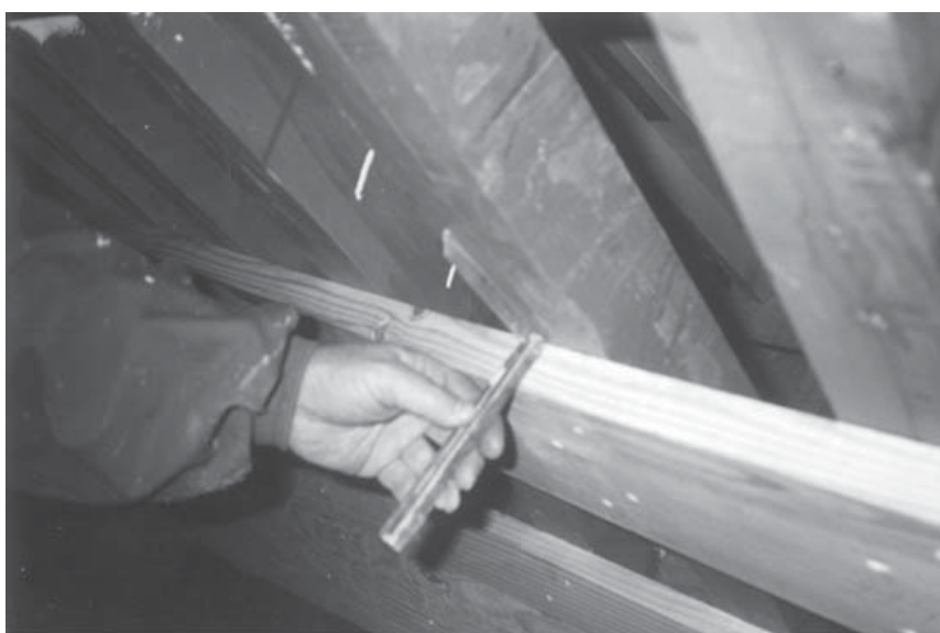
Figura 83.- Tomando ángulos con el cartabón.
