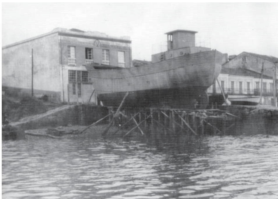
Figura 126.- Uno de los barcos de cabotaje en construcción en el astillero de Vila.
