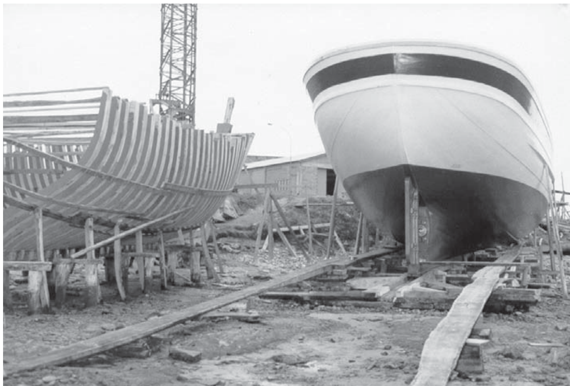
Figura 50.- Popa de parrulo en un pesquero construido por Jesús Nécega Gayo en su astillero de Foz, Lugo.
