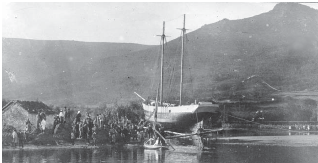
Figura 122.- Patache construido por José Lage García en Feas.
