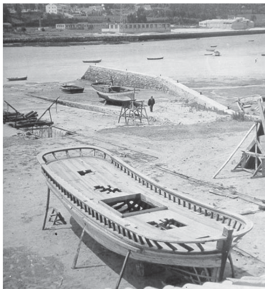
Figura 128.- Tarrafa en construcción en Astilleros y Talleres BAPA, en agosto de 1949.
