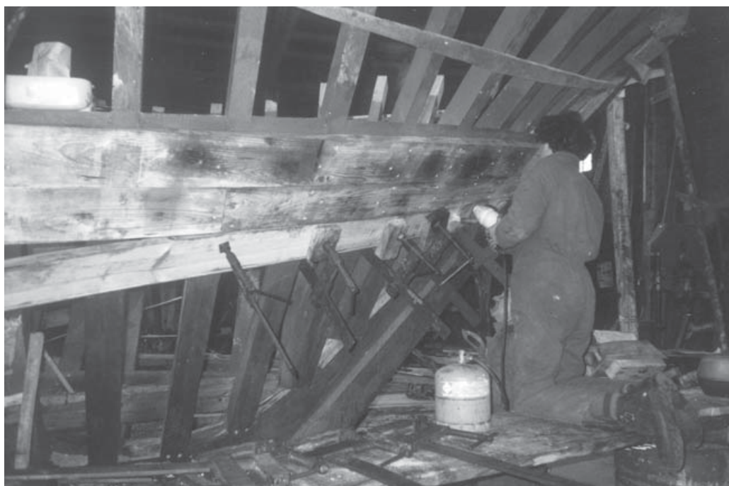
Figura 84.- Conformado de los bances de proa con soplete de gas.
