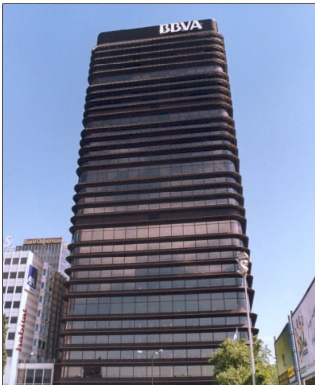
Edificio emblemático de BBVA, que constituye su principal sede operativa en Madrid.
