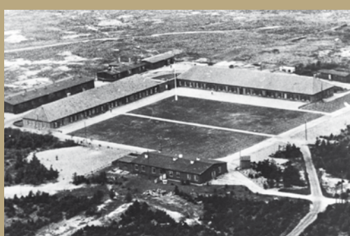
1. Das Lazarett A wurde 1941 von der Wehrmacht errichtet. Heute Oksbøl Jugendherberge.
