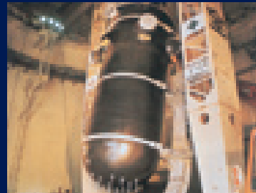
▲1号機原子炉容器搬入
