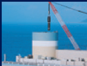
▲1号機蒸気発生器取替工事
