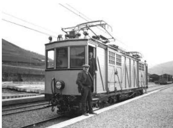
Automotor de mercancías del Ferrocarril del Urola, primero en España electrificado a la tensión de 1.500 voltios en corriente continua.
