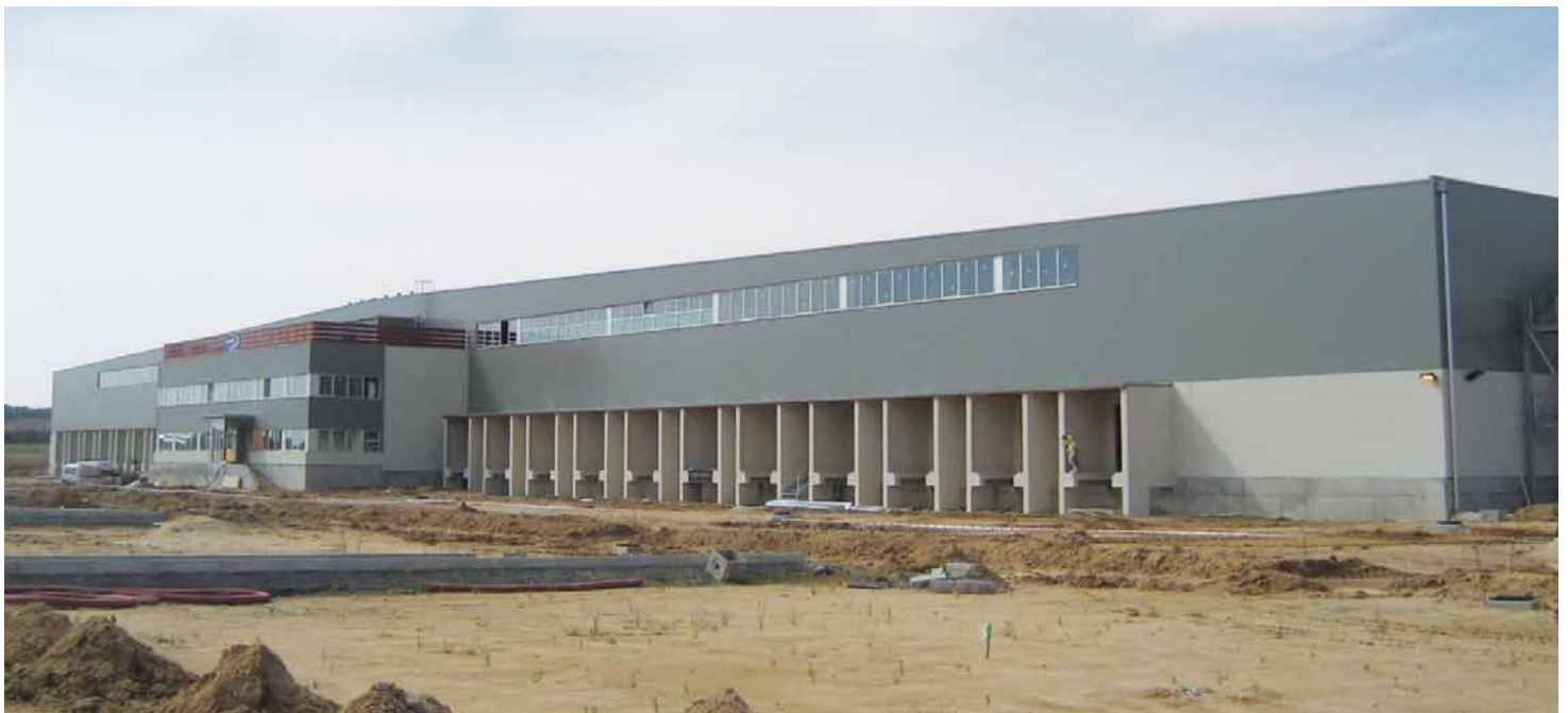
Fachada de la plataforma en construcción.
