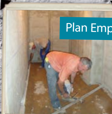
CONTINUAN A BUEN CURSO LAS OBRAS DEL INTERIOR DEL CENTRO DE DÍA Y VIVIENDAS TUTELADAS
