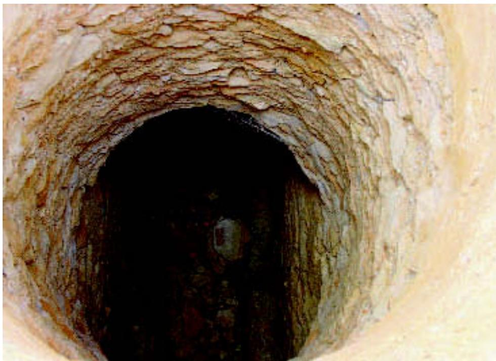
**Foto 2.1.7.** Parte basal de una de las lumbreras del sistema drenante de El Pulpillo. En el fondo se observa la galería horizontal que en este tramo se encuentra colmatada de escombros por su eje central.
