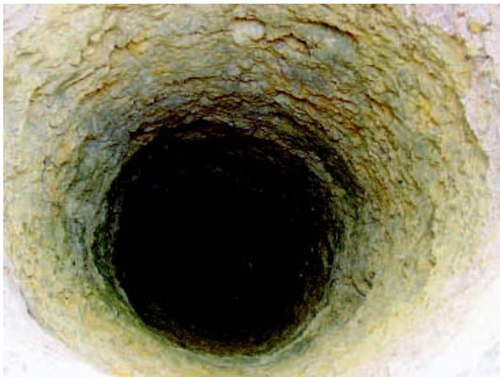
**Foto 2.1.4.** Una de las lumbreras del sistema de galería en El Pulpillo. El fondo de la galería alberga al menos en este tramo algo de agua.
