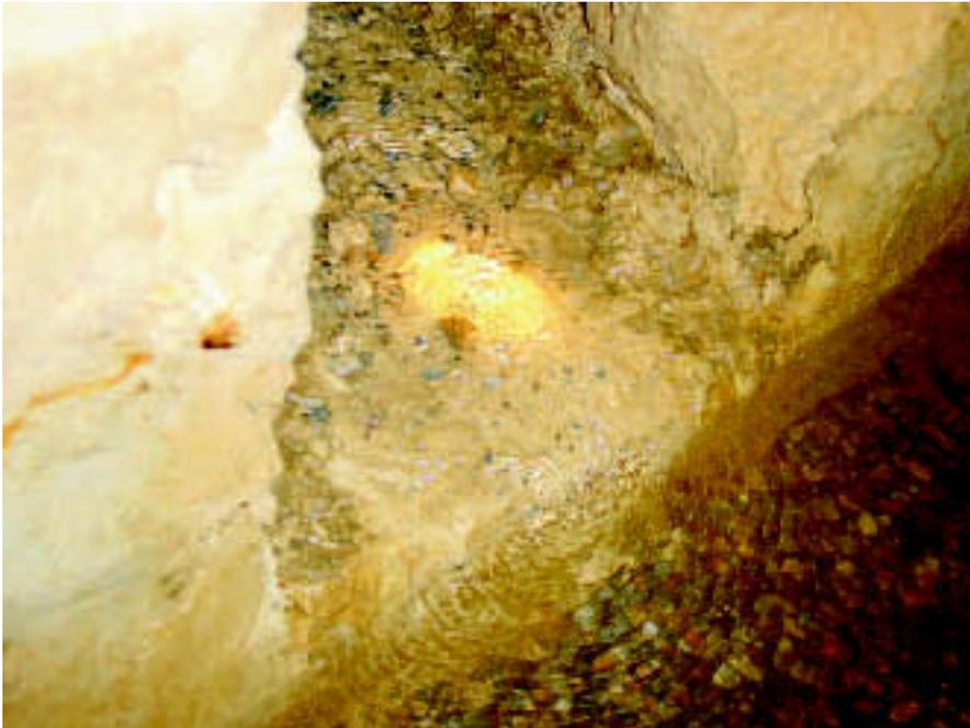
Foto 4.1.11. Detalle de una tronera, piqueta o mechinal en el Contracaño.
