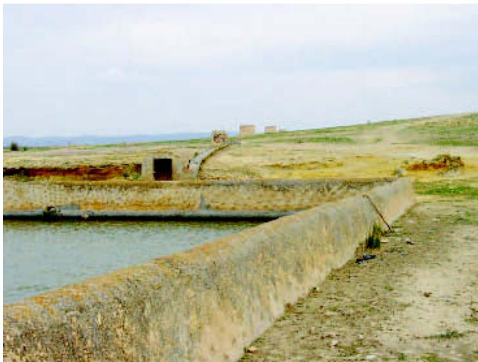
**Foto 2.1.2.** Fotografía de la balsa, bocamina y últimas lumbreras del sistema de la galería de El Pulpillo.
