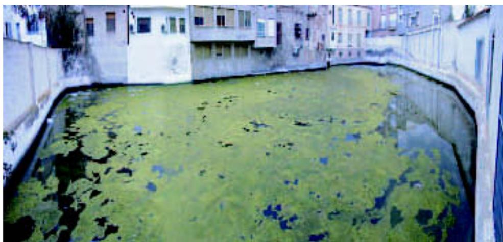
**Foto 4.1.7.** Balsa donde se acumulan las aguas captadas por el sistema de Caño y Contracaño en Nogalte (Puerto Lumbreras).
