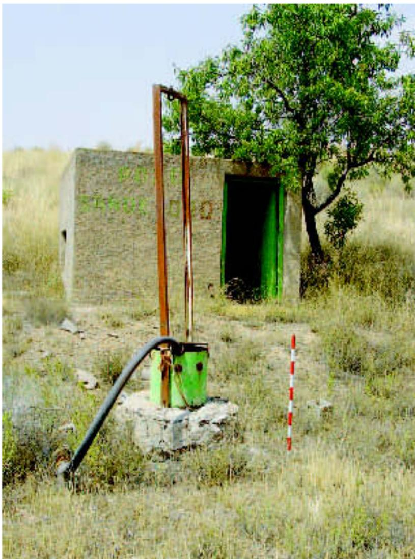
**Foto 5.2.2.** Extracción mecánica del agua mediante motobomba desde la lumbrera nº 2 de la galería.
