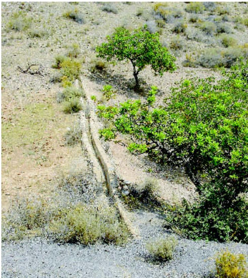
**Foto 5.1.6.** Pequeño canal que conducía el agua desde la bocamina de la vaguada hasta el encuentro con el ramal secundario que trasladaba el agua de Pinilla.
