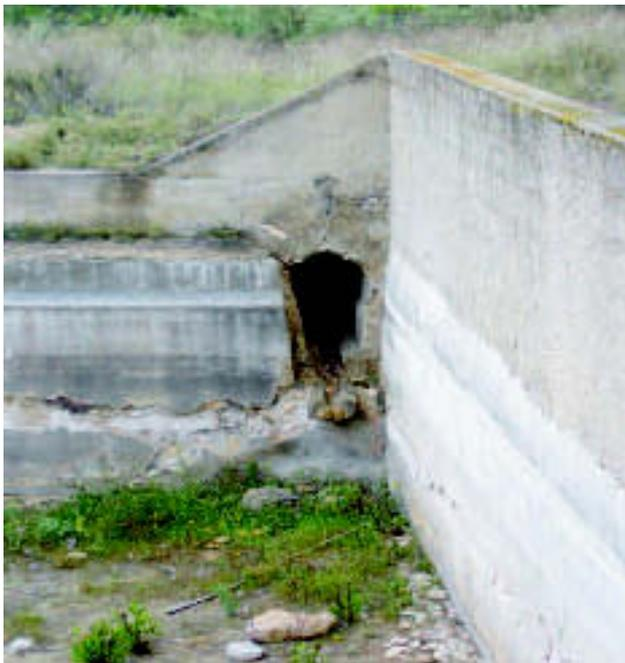
**Foto 3.2.4.** Salida de la galería directamente a la balsa.
