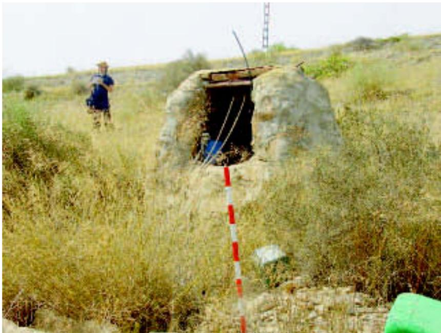
**Foto 5.1.4.** Lumbera del ramal proveniente de Cuesta de Gos rodeada por una cubierta de mampostería, donde hay instalada una pequeña polea que facilita la extracción del agua fluyente por la galería.
