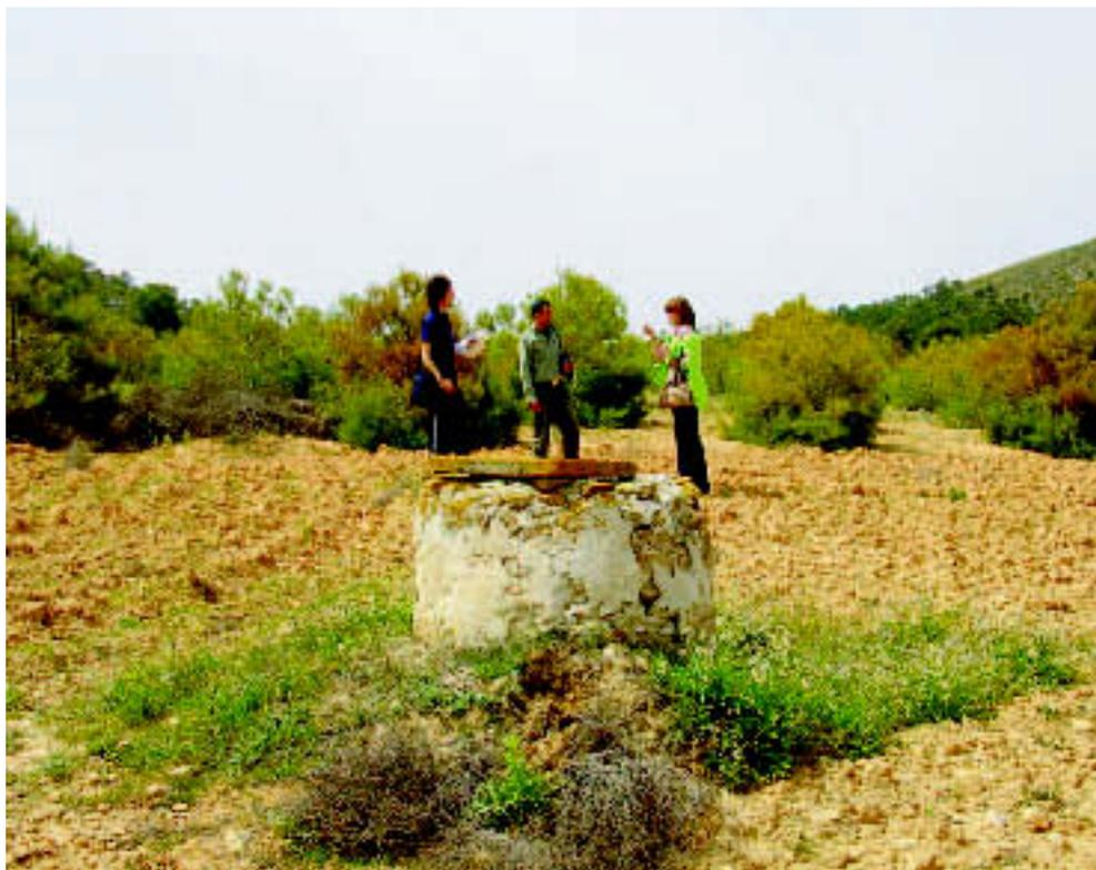
**Foto 2.2.5.** Una de las primeras lumbreras del sistema localizada en la cabecera de la rambla de Las Tobarillas.
