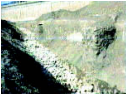
Foto 54. Presa subálvea y galería filtrante adosada: el Contracaño.
