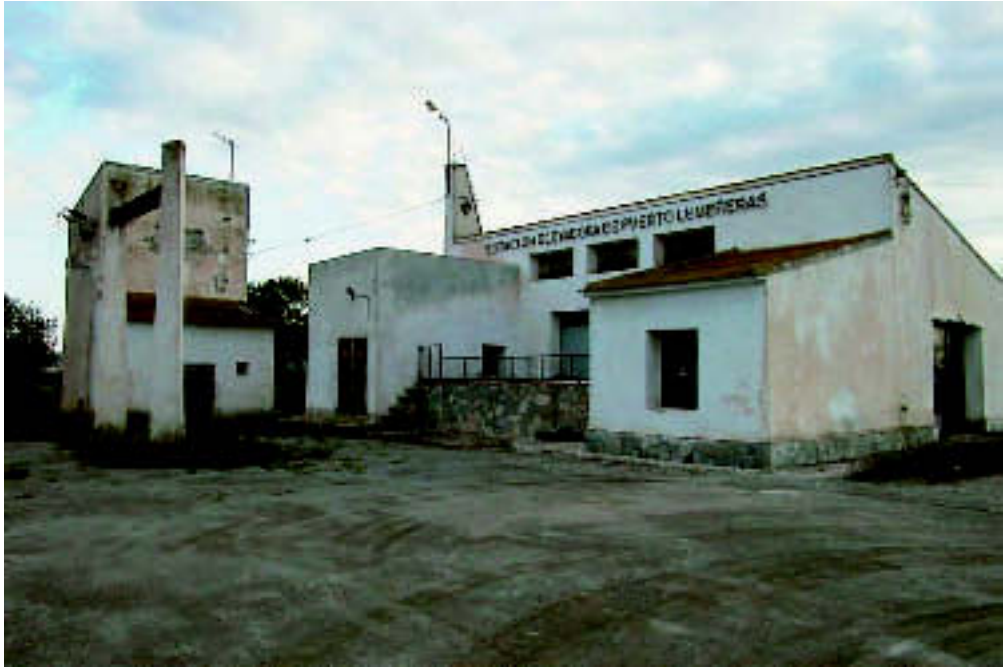
Foto 21. Estación elevadora de aguas de la Comunidad de Regantes de Puerto Lumbreras.
