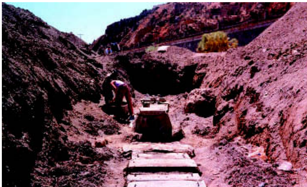
Foto 28. Sustitución de las lajas por prefabricado.
