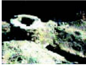
Foto 50. Las lumbreras de las galerías.
