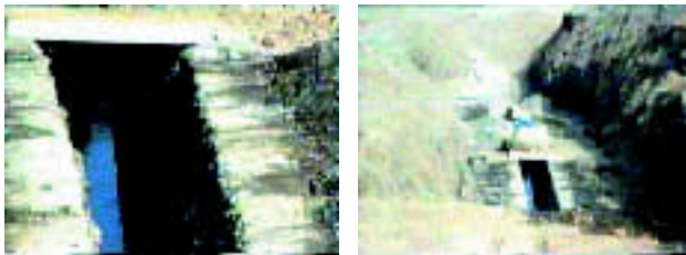
Foto 52. El agua en las galerías de Nogalte.
