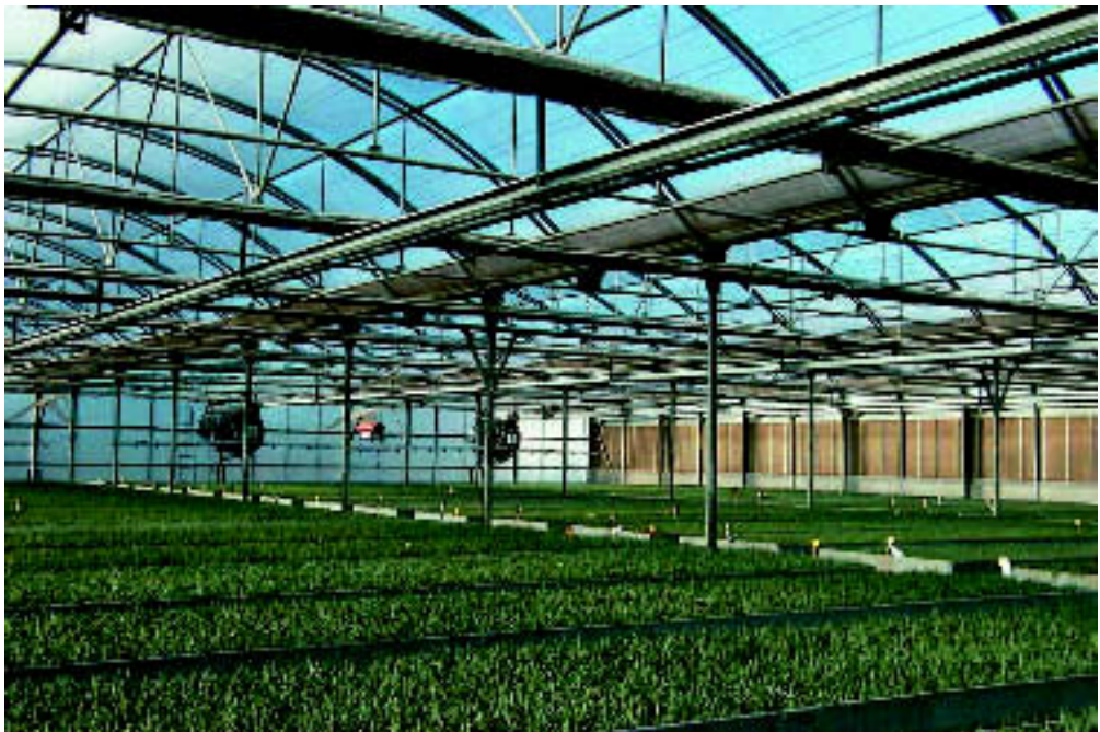
Foto 63. Aprovechamiento integral del agua en la Rambla de Nogalte (Puerto Lumbreras).
