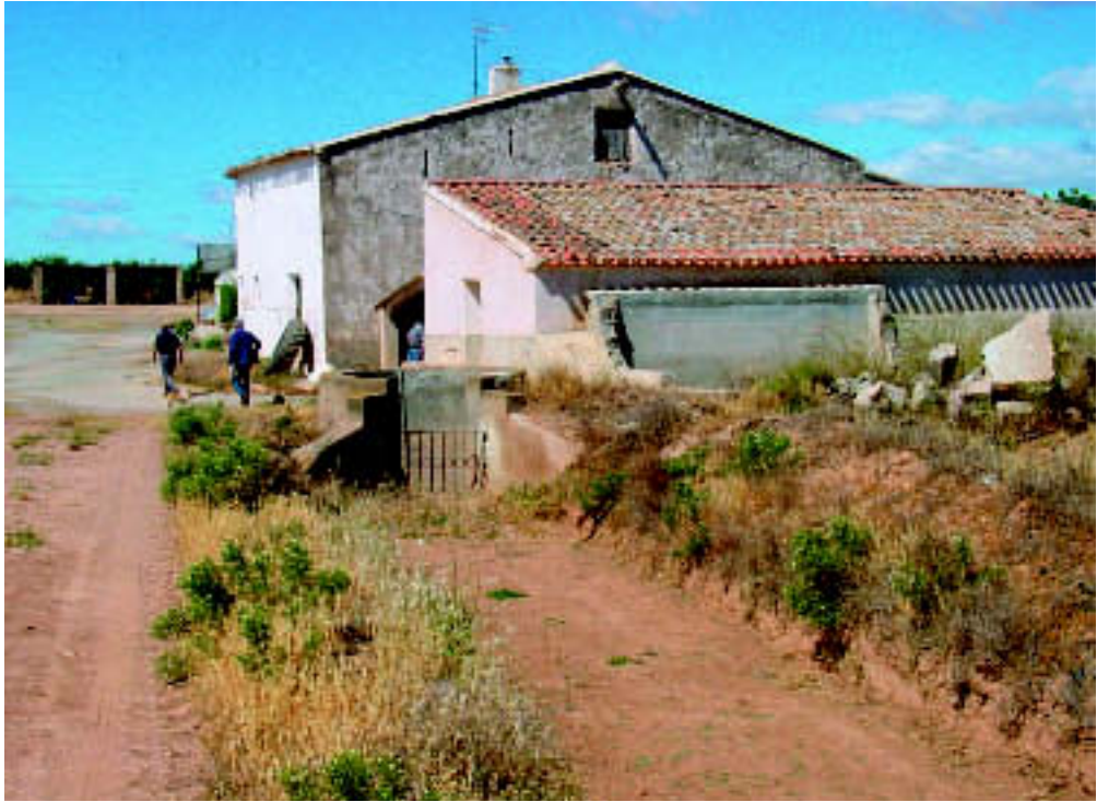
Foto 51. Aljibe de boquera vertiente. Boquera, aclarador, depósito acumulador.
