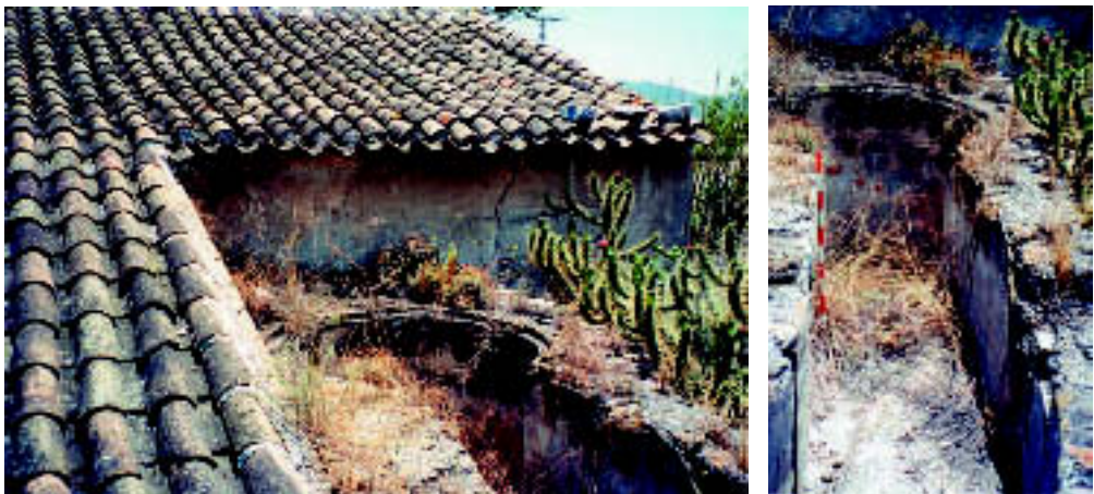
Foto 20. Molino de El Copo o de Ginés. Cuarto molino en la acequia. Caz y boca de cubo.
