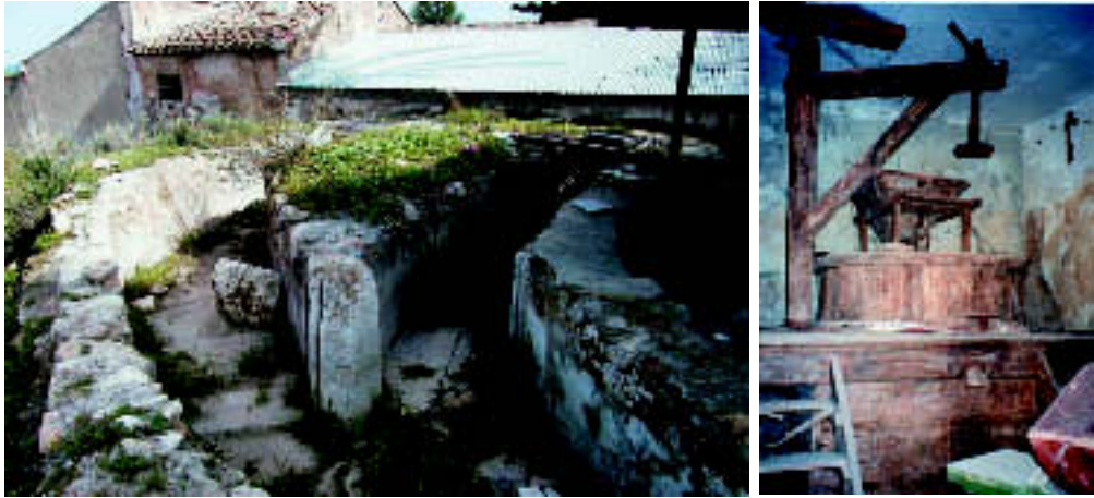
FOTO 17. Molino Jérez. Primero de los molinos. Caz de acceso a los cubos e interior del casals del molino.
