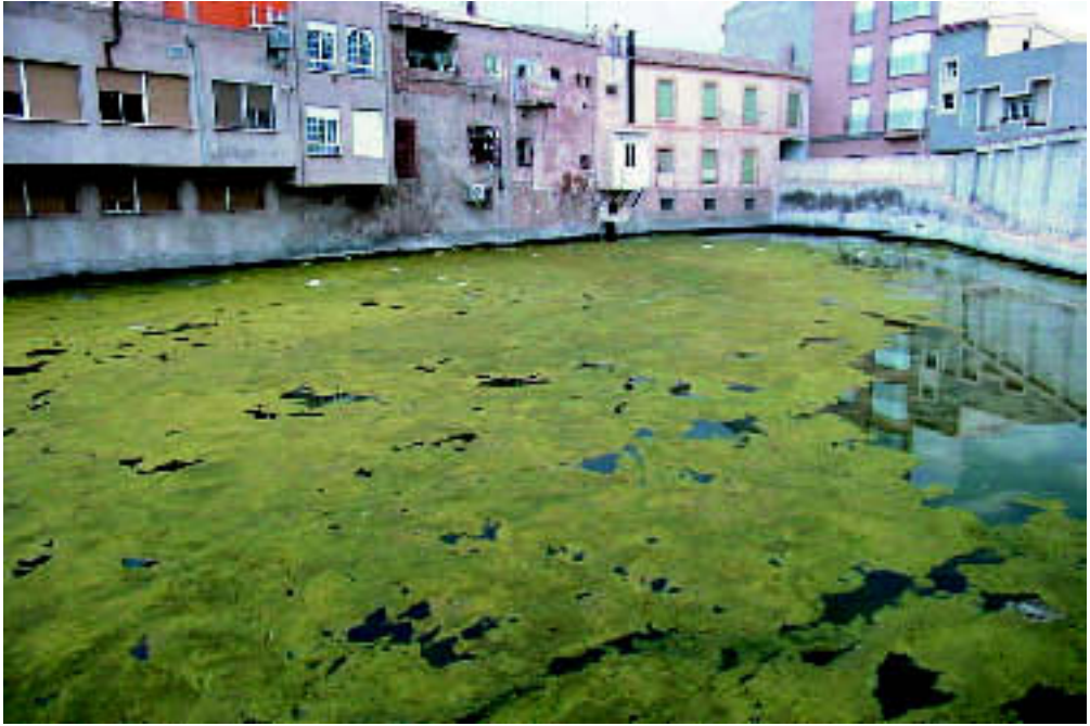
Foto 36. Sector NE de parte de la Balsa de la Sociedad de Aguas en Puerto Lumbreras.
