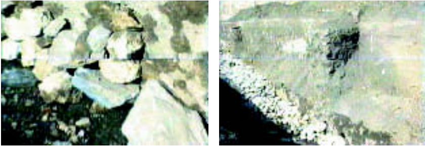
Foto 45. Detalle de las troneras y capa de piedra que se antepuso a la galería del Contracaño para favorecer el alumbramiento de agua subálvea.
