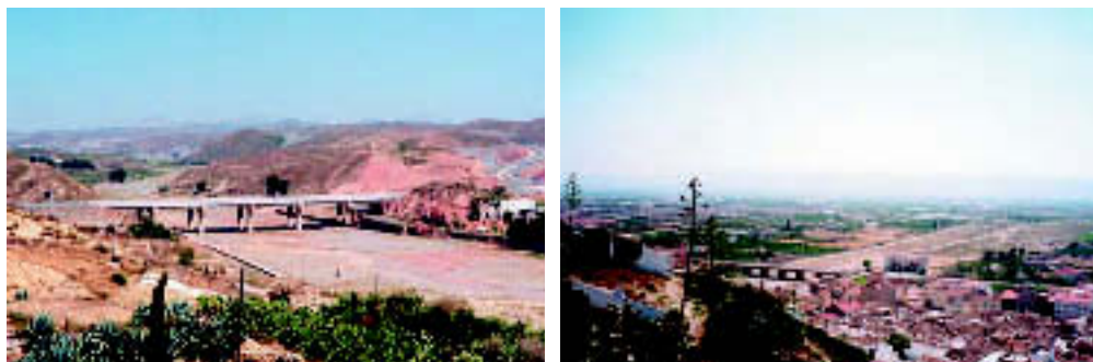
Foto 58. Sector aguas abajo del viaducto de la autovía y del puente de la C.N. 340 a Almería.
