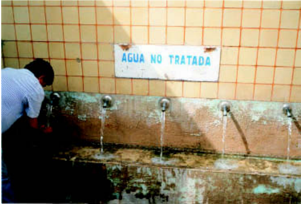
Foto 47. Los Caños en Puerto Lumbreras. Área tradicional de abastecimiento de agua para usos domésticos (año 1992).
