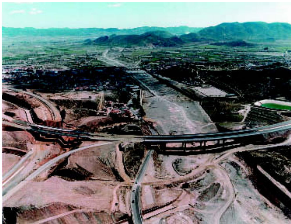
Foto 13. Viaducto y derrame de Nogalte en la Fosa del Guadalentín-Biznaga.
