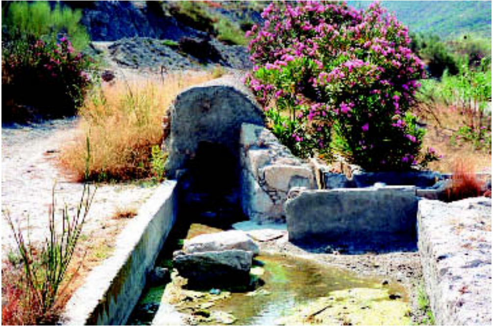
FOTO 4. Salida de la galería asociada a presa subálvea en la rambla de Béjar.
