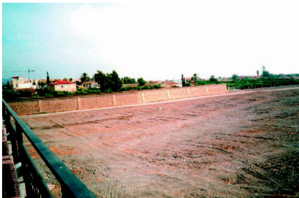
Foto 6. Prolongación muro en margen izquierda de la Rambla de Nogalte.
