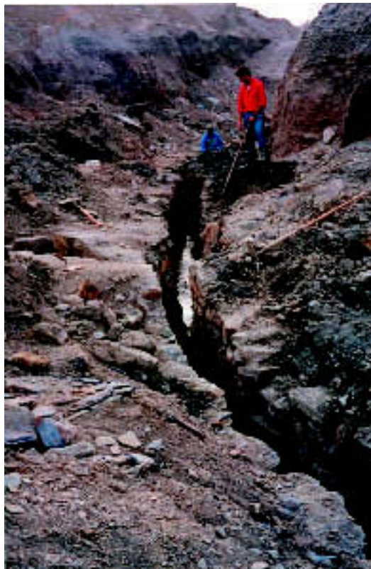
FOTO 27. Limpieza y obras en las galerías más antiguas (1995).
