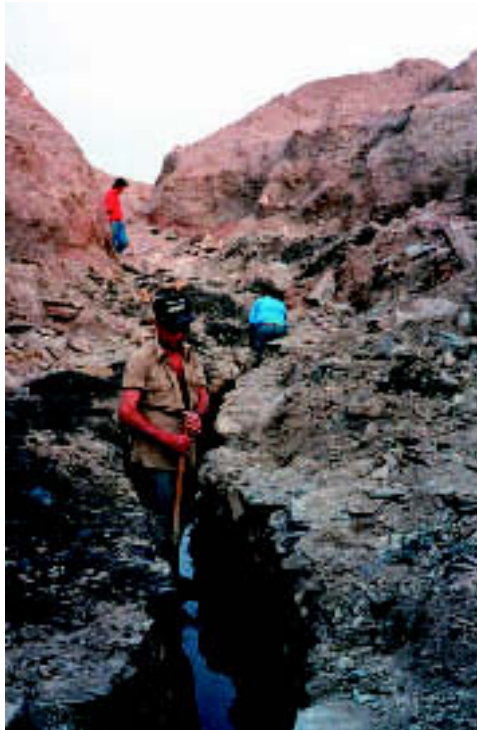
FOTO 34. Limpieza y obras en el Caño Viejo (1995).
