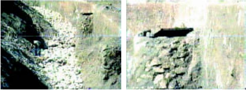
Foto 55. El Sistema se completa a finales del siglo XIX. Detalles del Contracaño.
