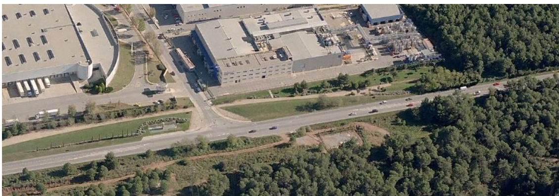
Il·lustració 2 Vista aèria del tram a desdoblar de la B-124 a l'alçada del polígon del Pla de la Bruguera
