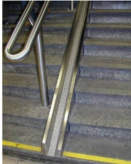
Ejemplo de adecuación de las instalaciones para su uso con bicicletas. (Bruselas)
