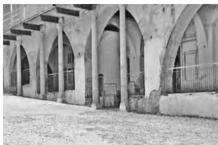
Πηγή: φωτ. Α. Παπαγεωργίου
