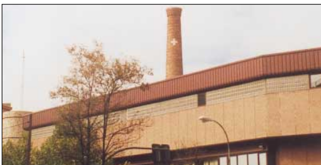
Foto actual conservándose la chimenea dentro de un complejo de tiendas-oficinas y aparcamiento.
