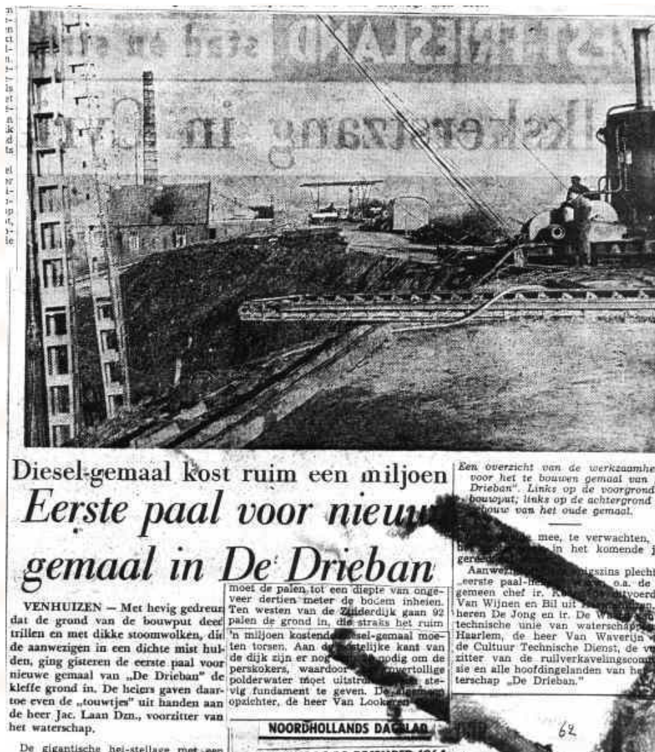
Afb. 74 Een bericht uit de krant over het heien van de palen voor het nieuwe gemaal. Het heien gebeurde met een Hollandse heistelling, een stoommachine met een valblok.
