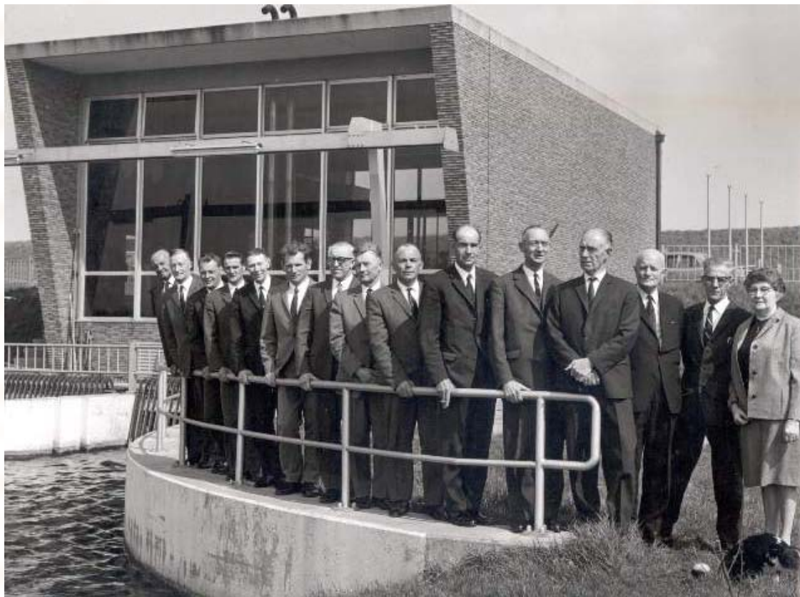
Afb. 105 Een foto van de opening van het nieuwe gemeaal. Op de foto staan van links naar rechts:
