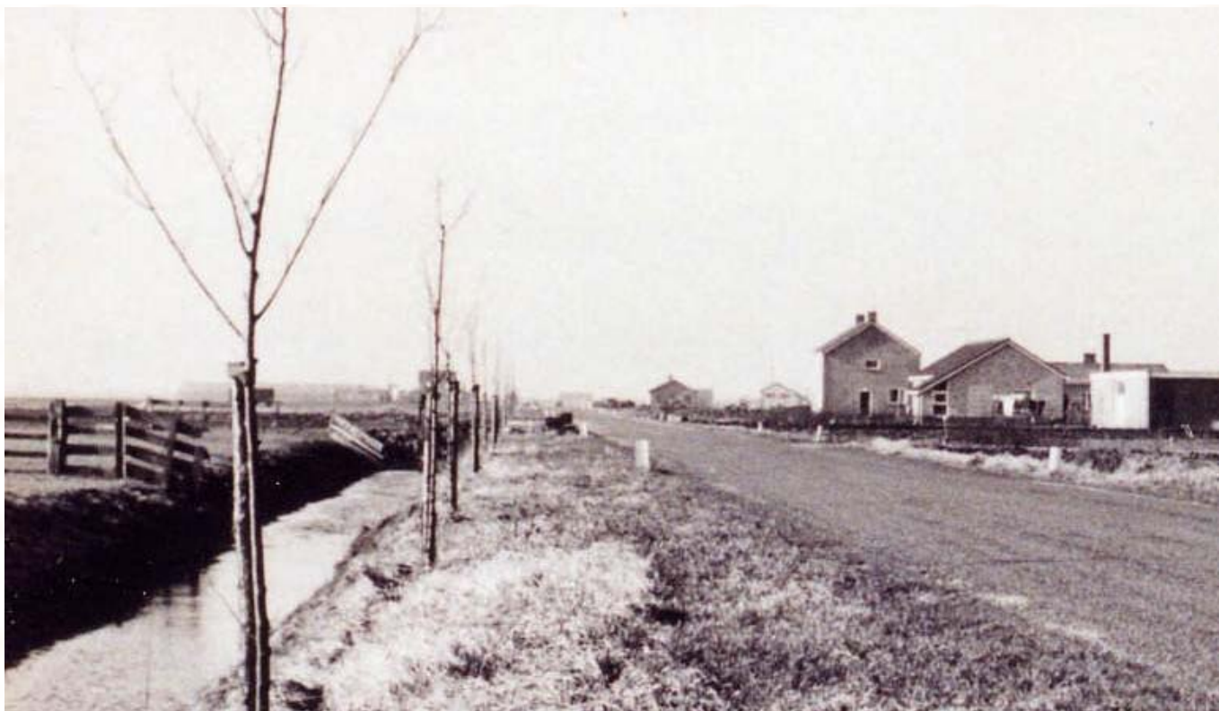
Afb. 108 Dit was polder De Drieban na de uitvoering van de RVK in 1970. Nieuwe bedrijven in een nog kaal landschap. Deze foto laat een beeld zien van de Elbaweg. De fotograaf stond aan de zuidzijde van de weg nabij de percelen Elbaweg 2 en 4.
