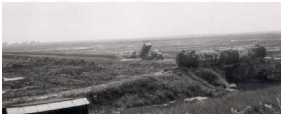
Afb. 57 De aanleg van de Burgemeester Zijpweg. Het zand wordt door een vrachtwagen van de firma Ooms uit Avenhorn aangevoerd. Deze vrachtwagens hadden een laadvermogen van 5 m 3 zand en waren afkomstig uit de legerdump. Voor dit werk waren ze voorzien van een kipperbak. Het voordeel van deze wagens was, dat deze op alle wielen konden worden aangedreven buiten de verharding.
