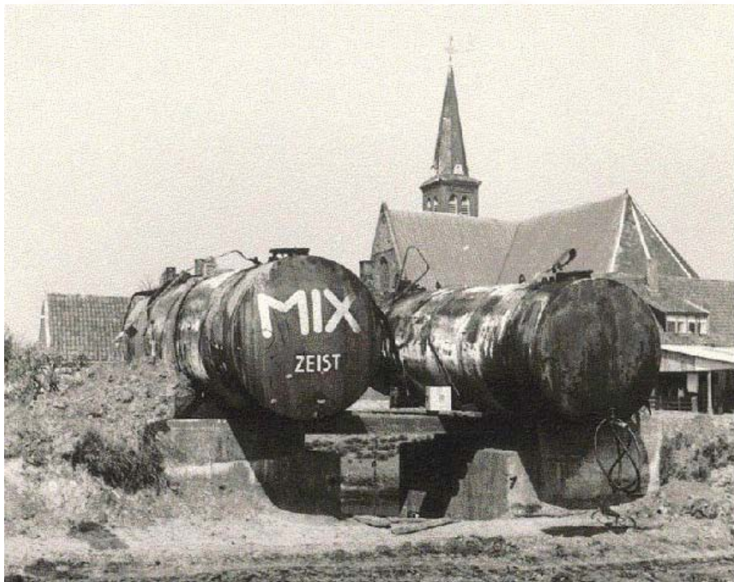
Afb. 71 De "energiepomp" van de AVOB. Deze grote olietanks waren gevuld met brandstof voor de vele machines. De tanks lagen op de oude spoorbrug van het Kerkwater. Tegenwoordig is dit absoluut ondenkbaar!
