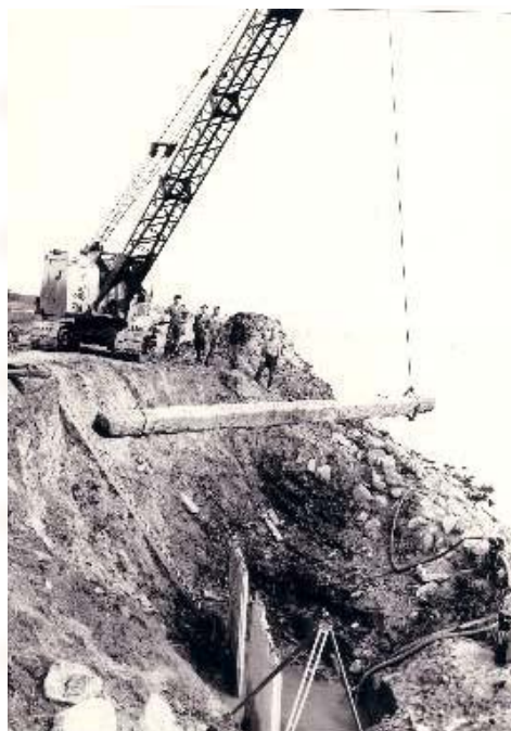
Afb. 72 Een foto van de aanleg van de inlaat bij de Appelhoek. Op de foto is de dragline van Blom bezig een heigording te verwijderen. Tussen twee van dergelijke gordingen was in het gegraven gat een betonnen damwand geheid met een uitsparing voor de inlaat. De damwand is nodig om lekkages langs de buis te voorkomen.
