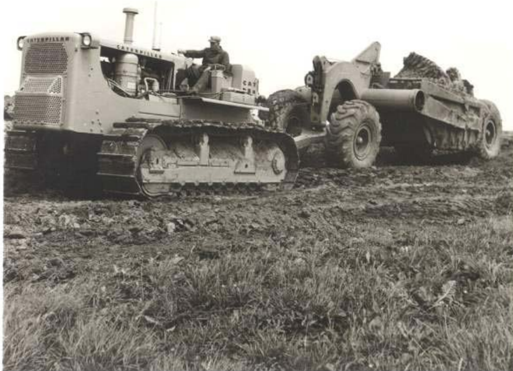
Afb. 82 Hier ziet u een zgn. scraper aan het werk. Achter de bulldozer was een voertuig bevestigd, dat tijdens het rijden zijn bak met grond kon voltrekken. De inhoud van deze bakken kon variëren van 15 tot 25 kubieke meter grond; al met al zeer zware machines.
