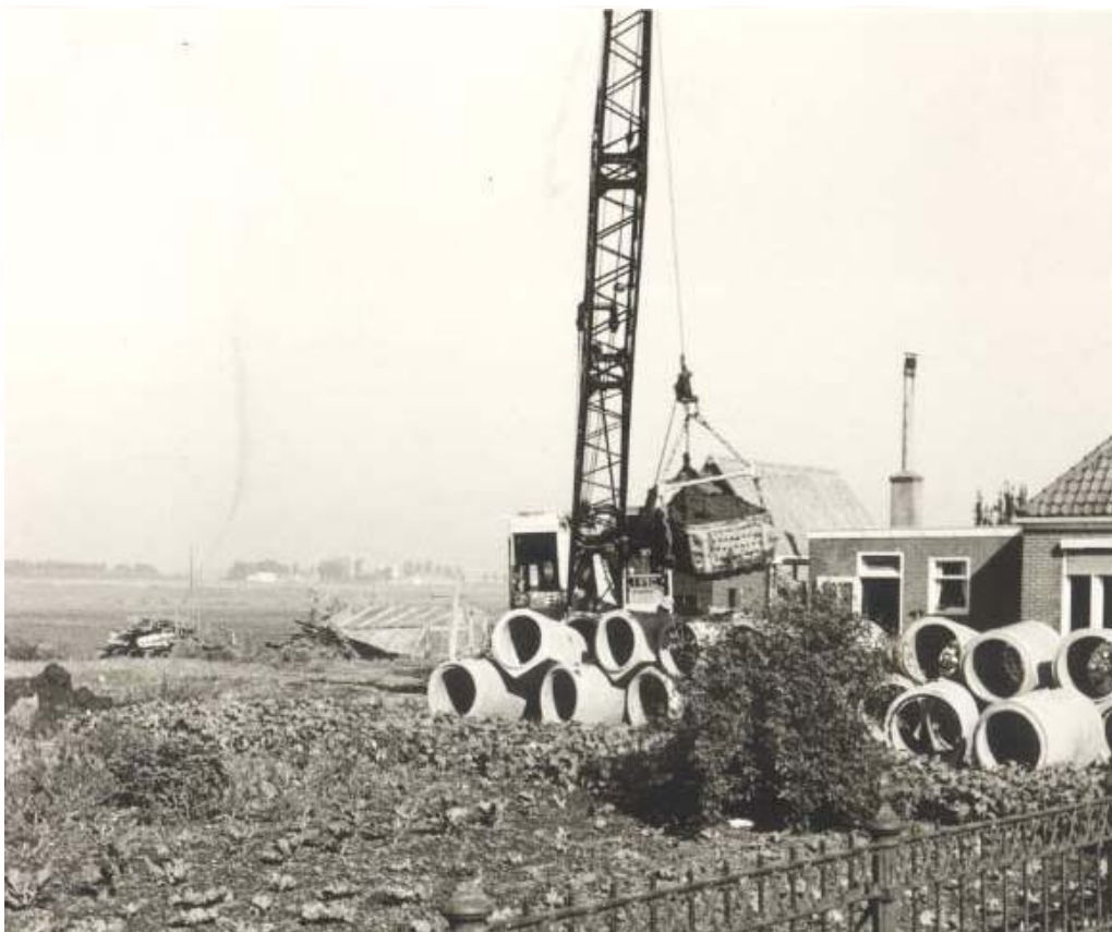
Afb. 66 Het maken van een duiker tussen de sloot, die achter de westelijke woningen van de Kerkweg loopt, en de zuidelijke wegsloot van de Stationslaan. Deze verbinding was nodig om de sloten aan de oostkant van dit gedeelte Kerkweg en Kerkeveld van water te kunnen voorzien. Voorheen was op deze plaats een brug.
