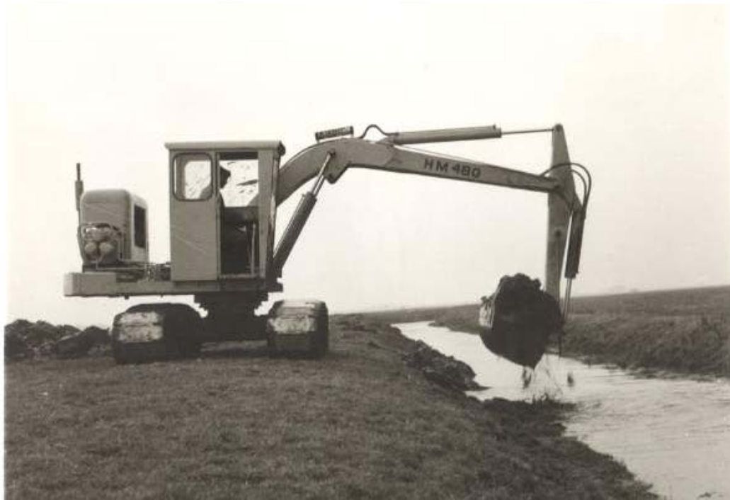
Afb. 76 Op de foto is een hydraulische kraan aan het baggeren. Dit was toen een nieuw type graafmachine en hij werd hier voor het eerst gebruikt. Dit type graafmachine is men verder gaan ontwerpen en hieruit zijn de huidige hydraulische graafmachines voortgekomen. Bij de afvoer van een van de machines van dit type heeft deze met zijn giek het viaduct van de spoorlijn geramd en is daarbij van de dieplader afgedrukt.
