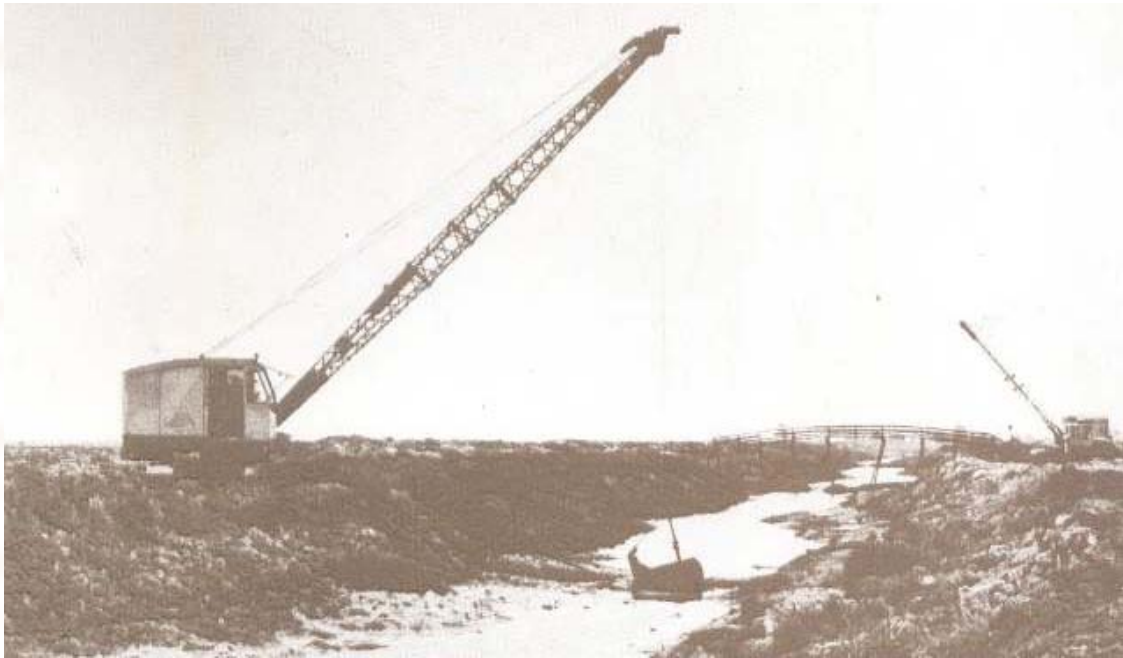
Afb. 67 Het baggeren van de Kadijk nabij de Hoge Steg.
