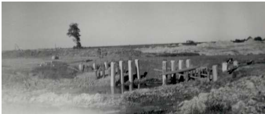
Afb. 62 De geheide palen zijn de palen voor de brug over de Kadijk in de Lakemanweg. De palen zijn geheid in een dam die in de Kadijk is aangebracht. Doordat de duiker in de Kerkweg nog niet was geplaatst, gaf dit in het najaar de nodige wateroverlast. Ook het oude gemaal toonde toen zijn gebreken.
