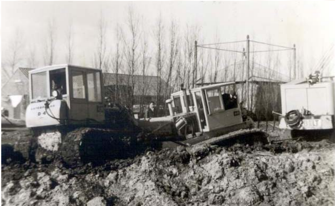
Afb. 78 Met de uitvoering ging het niet altijd van een leien dakje. Hier is de een bulldozer behoorlijk verzakt. Hij wordt geholpen door een dragline en een andere bulldozer, die hem uit zijn benarde positie bevrijden.
