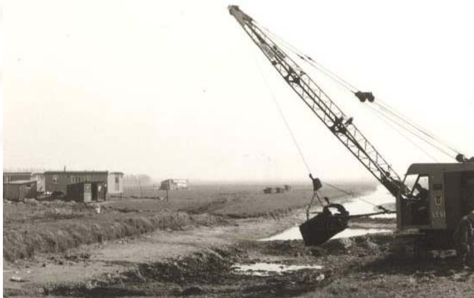
Afb. 54 Het baggeren van het Kerkwater, bekeken van de westkant. Links op de foto is het zogenaamde AVOB dorp zichtbaar. Deze plaats is nu een onderdeel van de Burgemeester Honijkstraat. Het gedeelte sloot waar de dragline aan het baggeren is, is nu de Burgemeester Zijpweg ongeveer tegenover de Zeger Davidsonweg.
