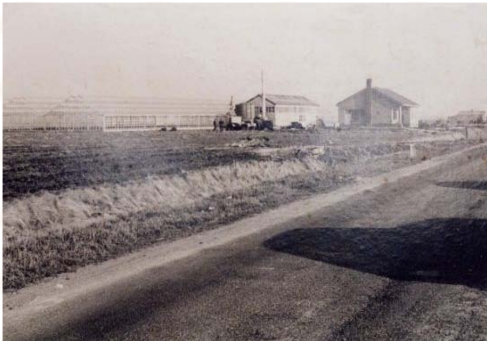
Afb. 110 Dit is een kassenbedrijf aan de Elbaweg. De kas wordt met een oliekachel gestookt, zie de olieketel en de schoorsteen.
