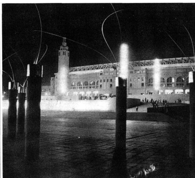
Die Fassade blieb. Das Olympiastadion auf dem Montjuic wurde von geschichtsbewußten katalanischen Architekten modernisiert. Foto: Respek
