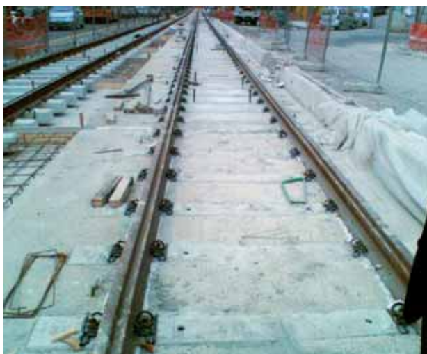
Fase di montaggio binario
