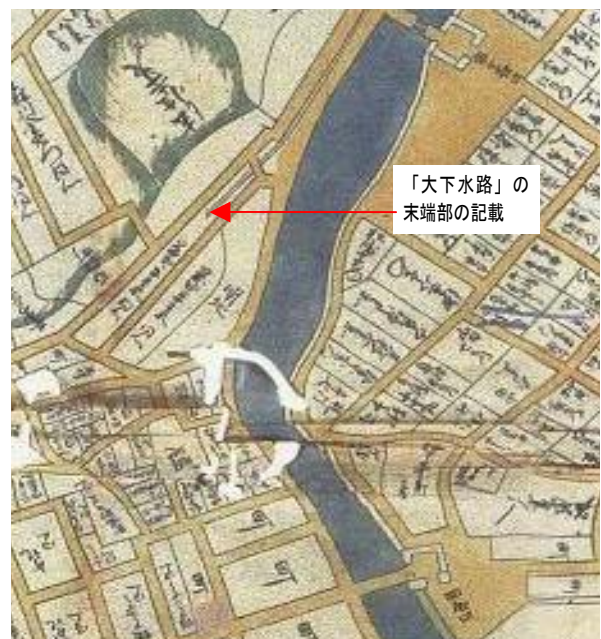
図 2.5 道筋に並列して敷設された大下水路の末端部 3) 図 2.4 の拡大図で旧紅葉川に沿った流路の末端部
