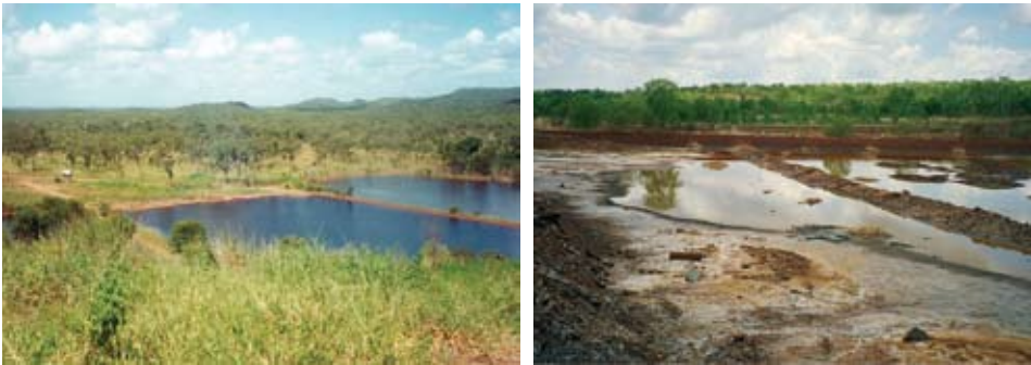
Gambar 18: Lahan basah dibangun untuk menyemir (polish) rembesan dari satu timbunan batuan sisa yang tertutup. Panel kiri menunjukkan lahan basah pada tahun-tahun awal ketika drainase masih netral. Panel kanan menunjukkan lahan basah setelah ia kewalahan dan menjadi tidak efektif akibat terobosan rembesan yang sangat masam dan kaya logam.
