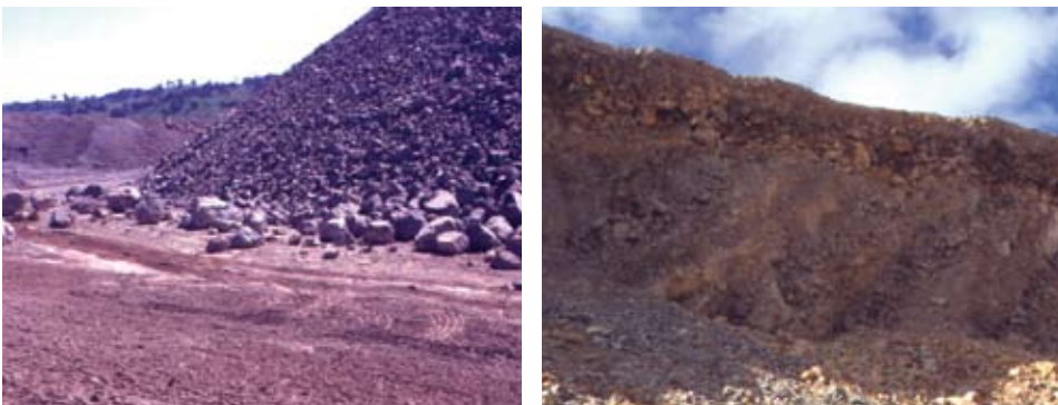
Gambar 10: Zona landasan batuan-serpih atau base rubble zone (gambar kiri); lapisan sudut kritis timbunan atau angle of repose dan lapisan yang dilewati lalu lintas kendaraan tambang atau trafficked layers (gambar kanan)
