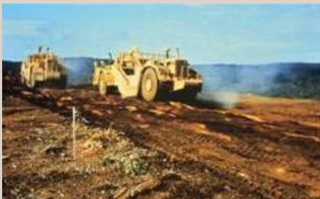
Mengupas (pengupasan) tanah lapisan atas
