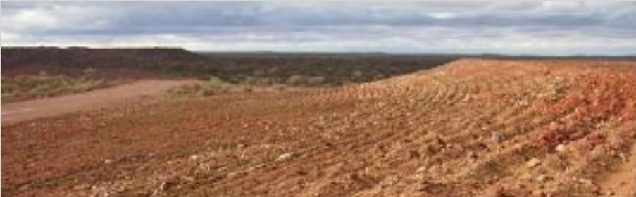
Lereng cekung di operasi penambangan nikel Murrin Murrin tak lama setelah konstruksi
