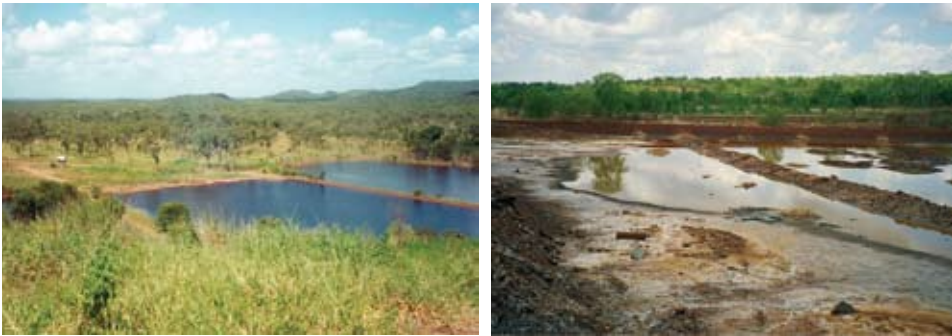
Hình 18: Vùng đất ngập nước được xây dựng để loại bỏ hiện tượng thẩm từ khu đá thải được phủ. Phần bên trái là vùng đất ngập nước trong những năm đầu thoát chất trung hòa. Phần bên phải là vùng đất ngập nước sau khi đã bị chôn vùi và trở nên không còn hiệu quả do sự phát triển của các dòng thấm có hàm lượng kim loại và tính axit cao.
