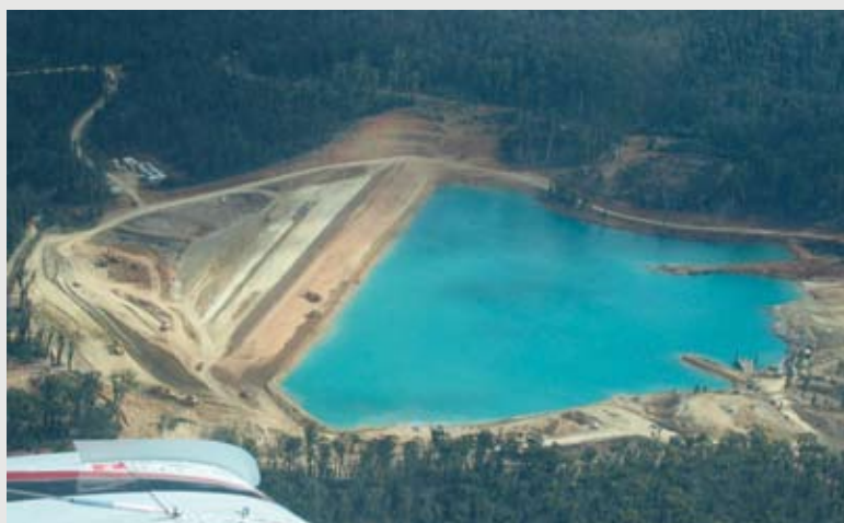
Hình 14: Ảnh máy bay Đập Benambra trong quá trình phục hồi
