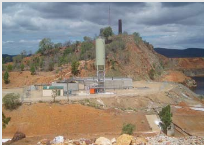
Hình 17: Nhà máy xử lý nước trong mỏ gần mỏ lộ thiên có chứa AMD ở Mt Morgan (Tháng 3 năm 2006)
