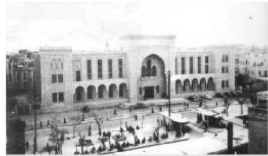
الصورة (4-3-2-8) 95 القصر العدلي القديم في شارع النصر
