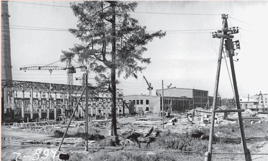
Общий вид строительства зданий № 301 и 303. 1959 г.
