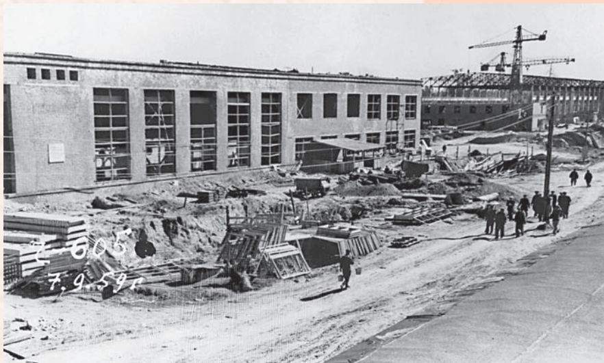
Стройплощадка около третьего производственного здания № 301. 1959 г.
