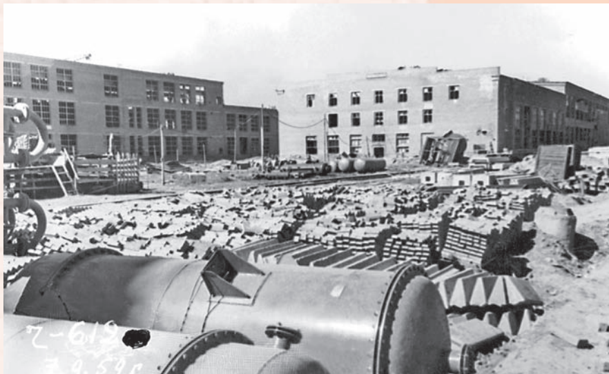
Площадка хранения стройматериалов и оборудования. 1959 г.
