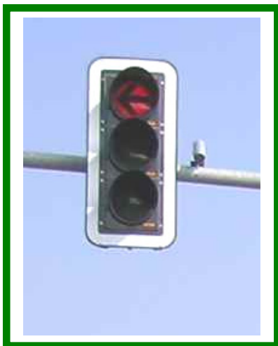
Bild 61a: Infrarotdetektor am Ausleger zur Fahrzeug-erfassung (Nahdetektion) (Foto: D. HOFMANN)
