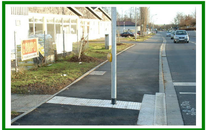
Bild 93: Übergang von Gehweg zur Fahrbahn mit Aufmerksamkeitsfeld und „Kasseler Rollbord“ (ertastbarer Bord mit Nullabsenkung) (BOSSERHOFF 2007)
