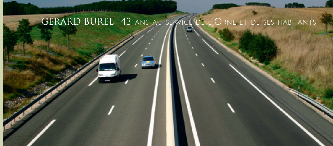
Parmi les importants chantiers routiers impulsés, celui de l'autoroute A28, mise en service en 2005
