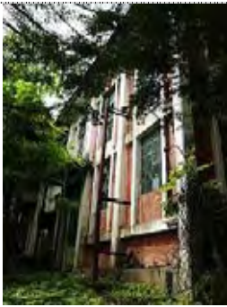
【北炭幌内炭鉱変電所】 (北海道三笠市)
