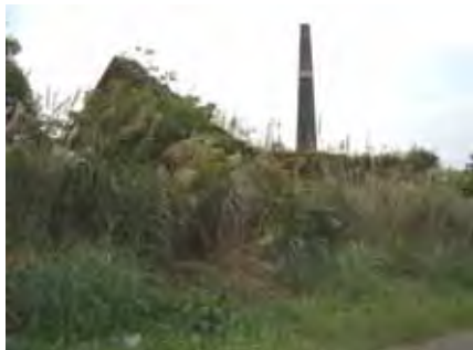
【旧中川煉瓦製造所機械場(手前)、ホフマン窯(奥)】 (滋賀県近江八幡市)
