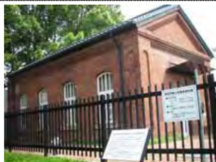
【熊本学園大学産業資料館（旧熊本紡績電気室）（移築）】
