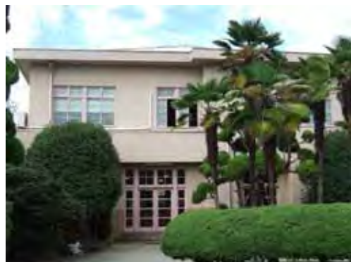
【東洋精機㈱ 本館事務所】 （兵庫県尼崎市）
