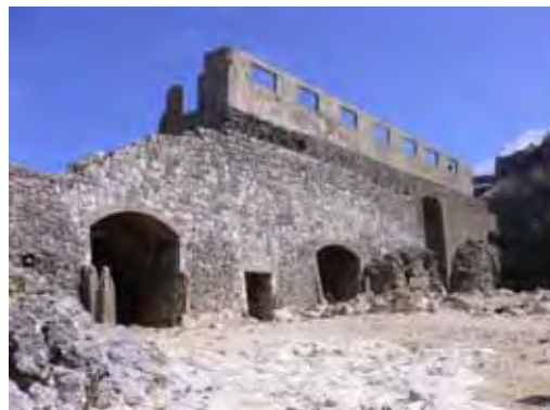
【旧東洋精糖燐鉱石貯蔵庫跡】 (沖縄県島尻郡北大東村)
