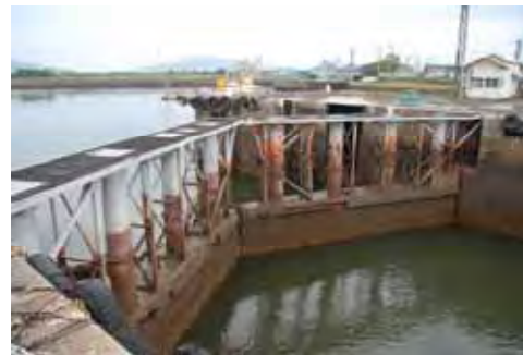
【三池港閘門】 （福岡県大牟田市）
