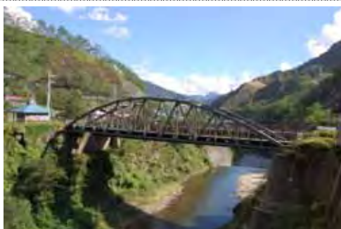
【古河橋】 (栃木県日光市)
