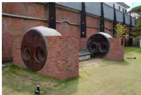
【旧中林綿布工場（ランカシャーボイラー）】
