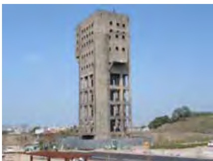
【志免鉱業所竪坑櫓】 （福岡県粕屋郡志免町）
