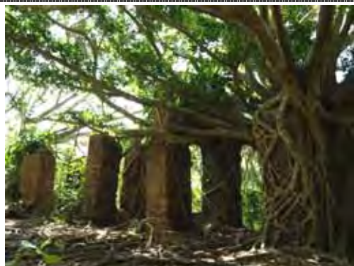
【宇多良炭鉱跡 橋梁跡】 (沖縄県八重山郡竹富町)
