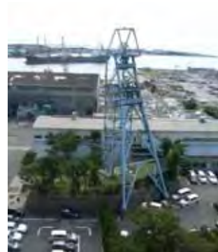
【沖ノ山電車竪坑石垣】 （山口県宇部市）
