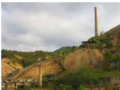
【尾去沢鉱山跡】 （秋田県鹿角市）
