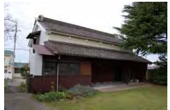
【フジハン醤油旧米蔵】 (千葉県香取郡神崎町)
