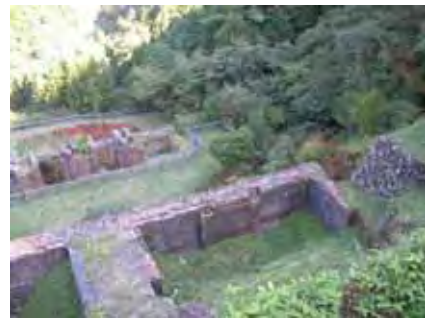
【別子銅山 マイントピア別子東平ゾーン(東平貯鉱庫跡)】 (愛媛県新居浜市)
