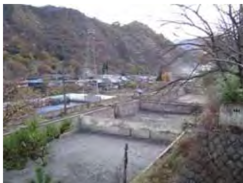
【間藤浄水場】 (栃木県日光市)
