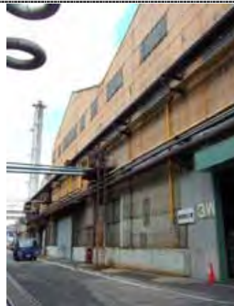
【住友金属工業㈱網管カンパニ - 特殊管事業所 鍛造管工場】 （兵庫県尼崎市）
