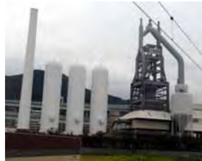
【東田第一高炉跡】 (福岡県北九州市)
