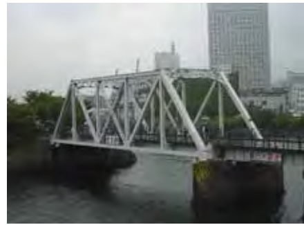
【旧臨港線港一号橋梁】 （横浜市西区）
