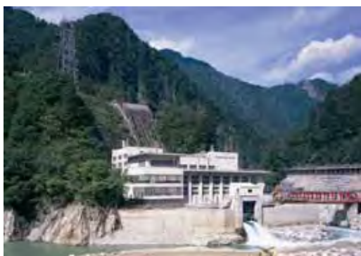
【黒部川第二発電所】 （富山県黒部市）
