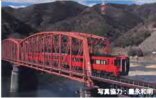
写真協力：豊永和明 【肥薩線 球磨川第二橋梁】 (熊本県球磨郡球磨村)
