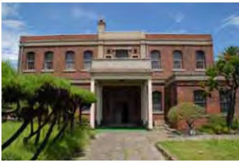
【ユニチカ記念館（旧尼崎紡績本館事務所）】 （尼崎市東本町）
