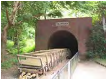
【常磐炭礦湯本坑第六坑坑口】 (福島県いわき市)
