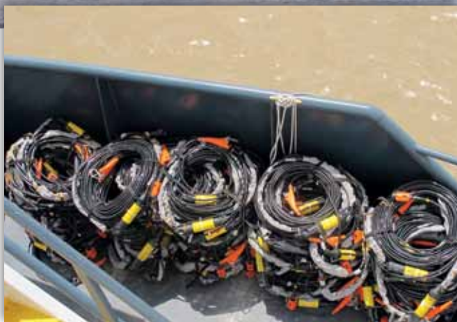
Deze kabels worden op de zeebodem gelegd.
