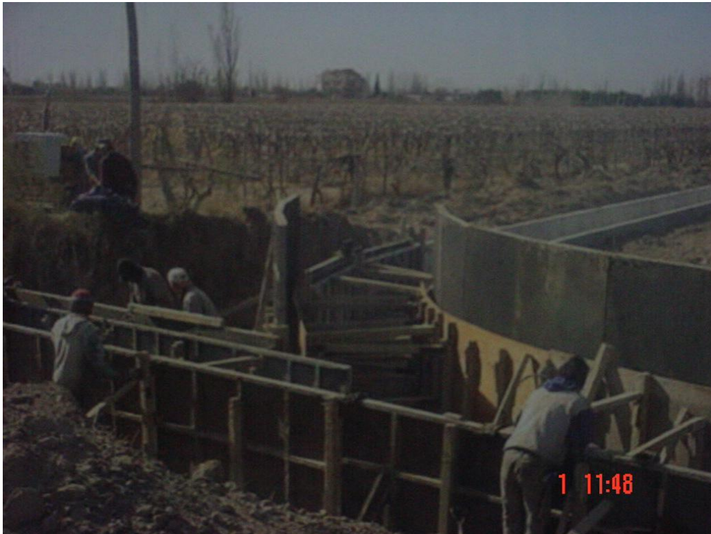
Obra de Impermeabilización del Canal Montecaseros.
