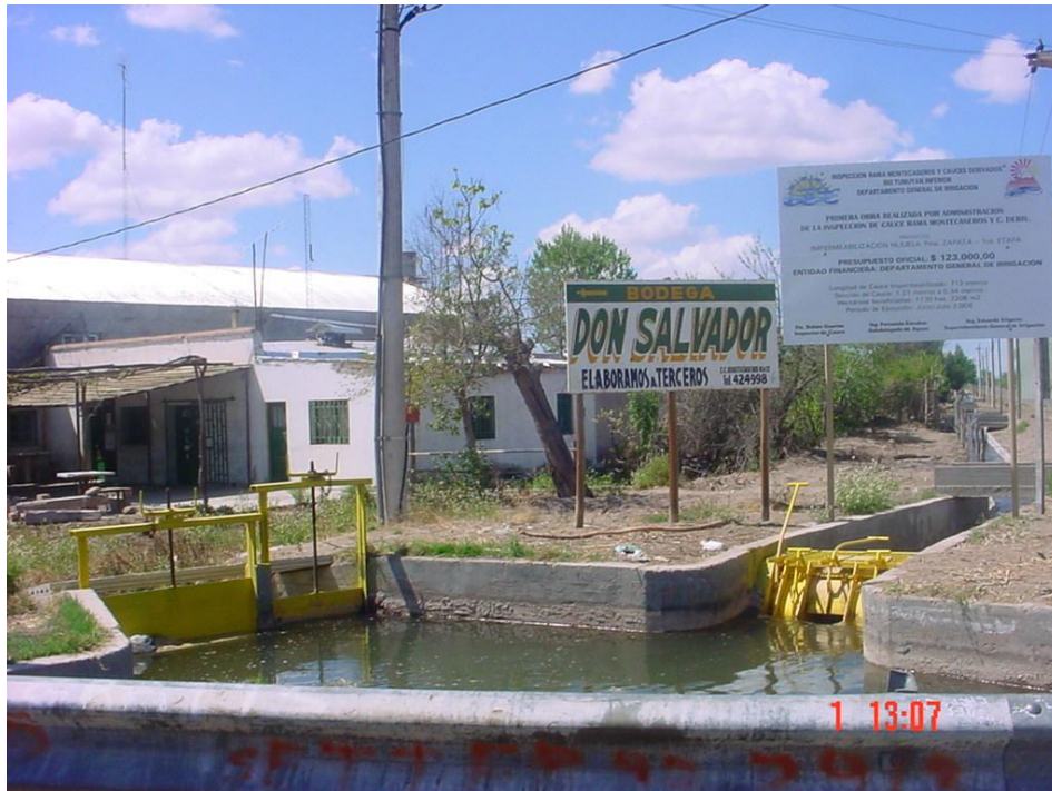
Vista de la 7° Hijuela Zapata. Se puede observar la compuerta de máscara y su capacidad para embalsar y enviar flujos constantes de agua para riego.
