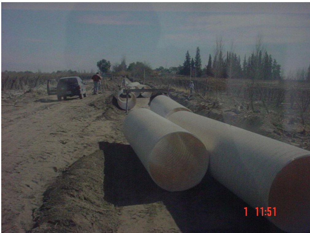
Obra de entubamiento de uno de los tramos del Canal Montecaseros.
