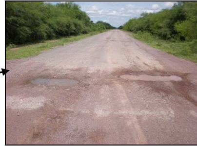
CAMBIO DE TIPO DE CALZADA
