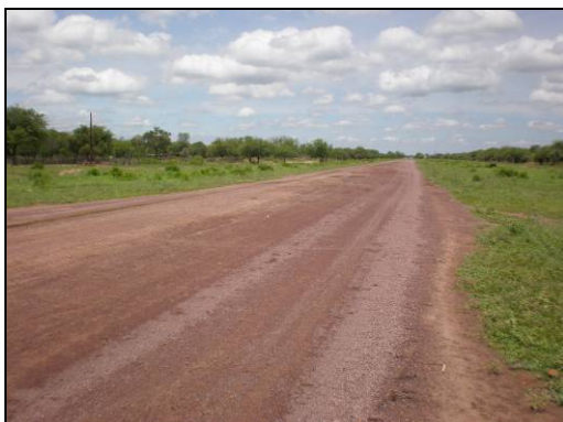
ESTADO GENERAL DEL TRAMO 2
