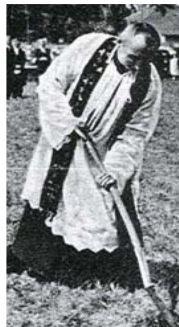
8 sierpnia 1937 roku ksiądz Alojzy Kozielek pierwszym wykopem w ziemi symbolicznie rozpoczyna budowę nowego kościoła w Knurowie
